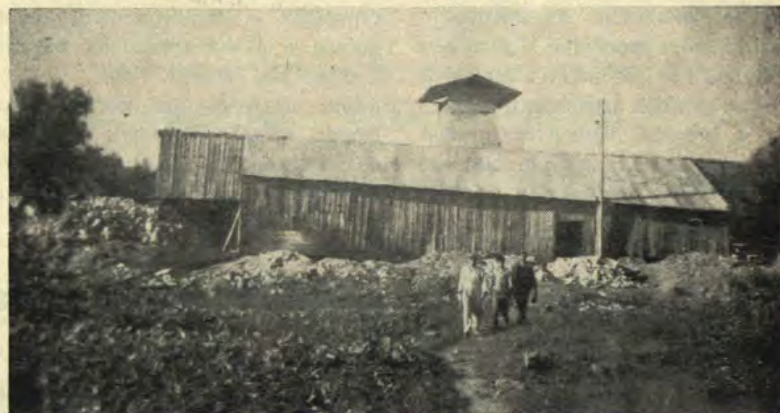
Um aspecto da entrada para uma Mina no Bairro (próximo de Chão de Couce).
