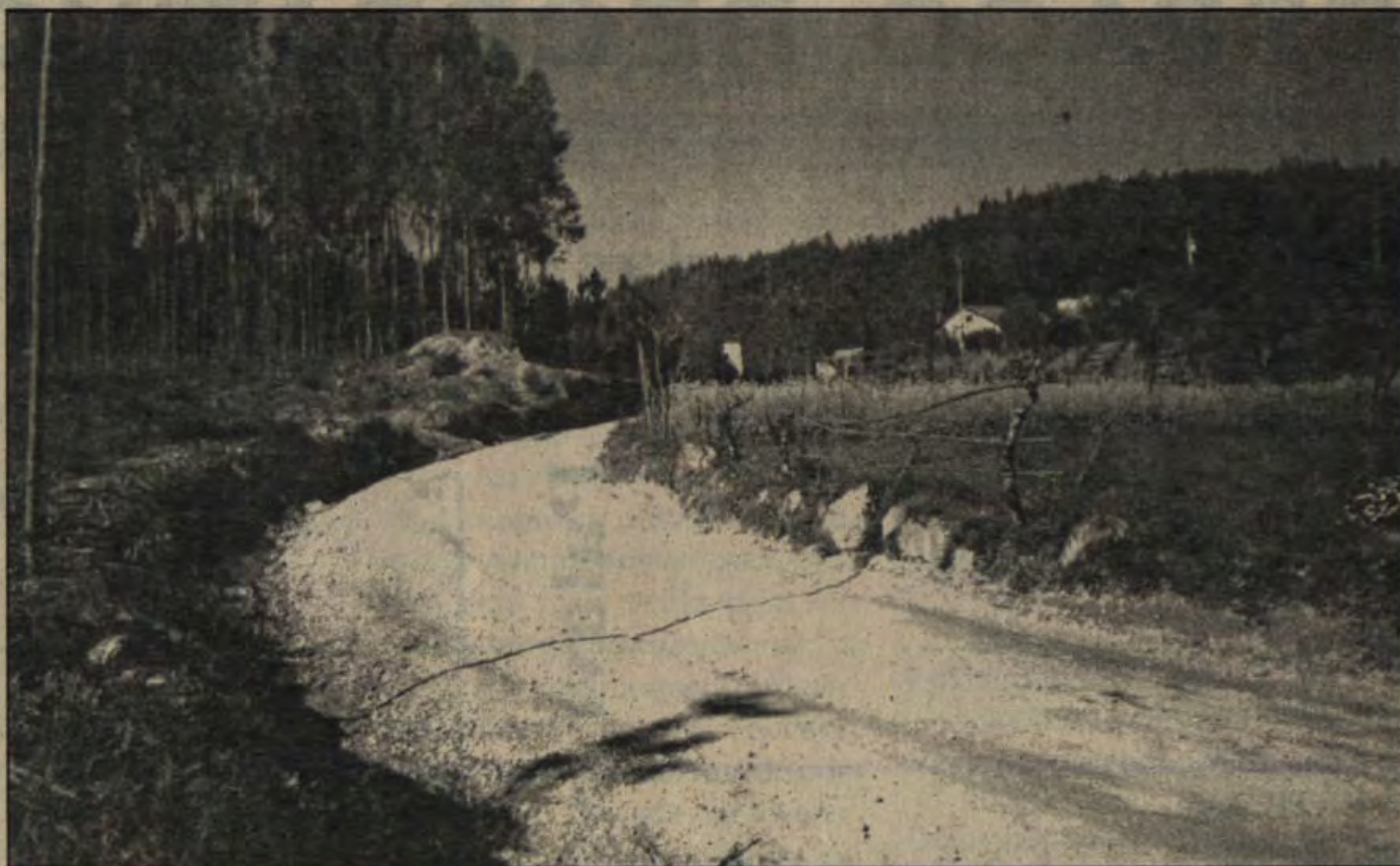
Aqui, no início do lugar Vale do Prado, terminará a parte competitiva do Rali de Portugal
