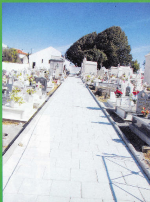
Obras de beneficiação no cemitério Municipal.
