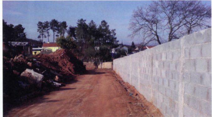
Alargamento e pavimentação de estrada em Bairradas.
