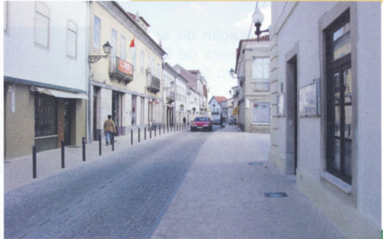
Benificação da Rua Dr. Manuel Simões Barreiro.
