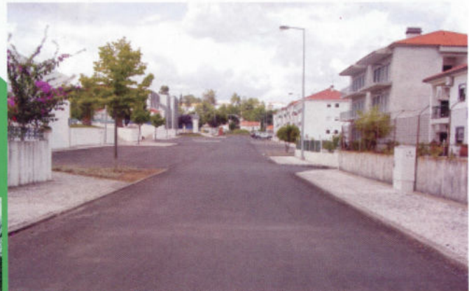
Pavimentação da Rua 25 de Abril
