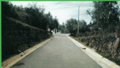
Pavimentação e construção de valetas na freguesia de Campelo.
