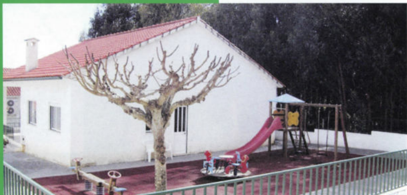
Construção de parque infantil em Arega.
