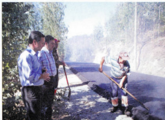
Pavimentação de estradas na Freguesia de Aguda.
