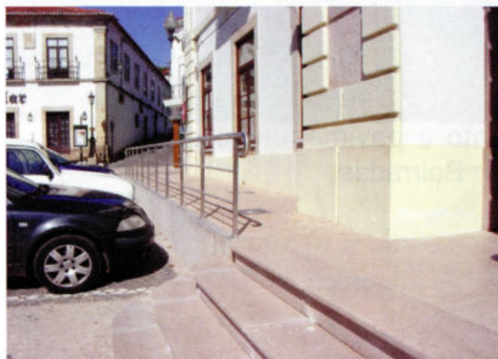
Pormenor da rampa de acesso para deficientes à entrada da Câmara Municipal
