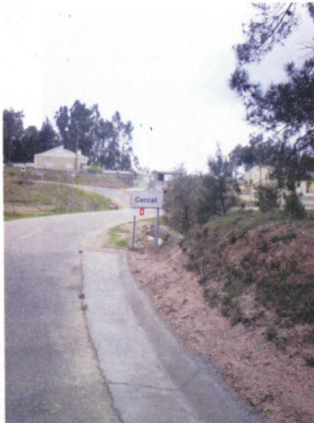
Execução de valeta em Cercal - Aguda
