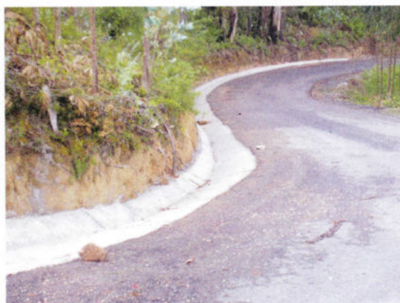
Execução de valeta em Casalinho - Arega
