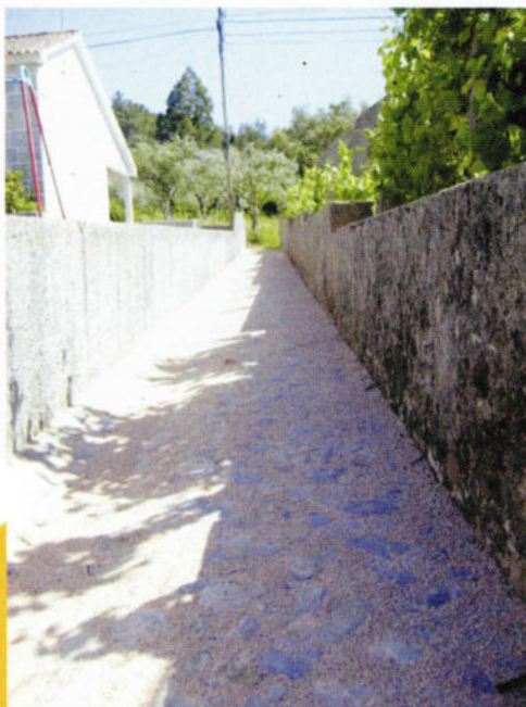
Execução de calçada em Vilas de Pedro - Campelo.
