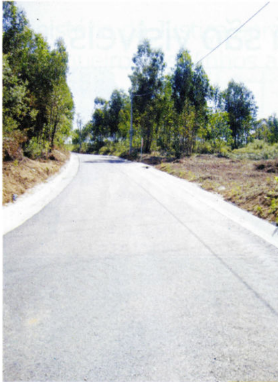
Pavimentação e beneficiação do caminho Rural da Coutada a Água D'Alta.
