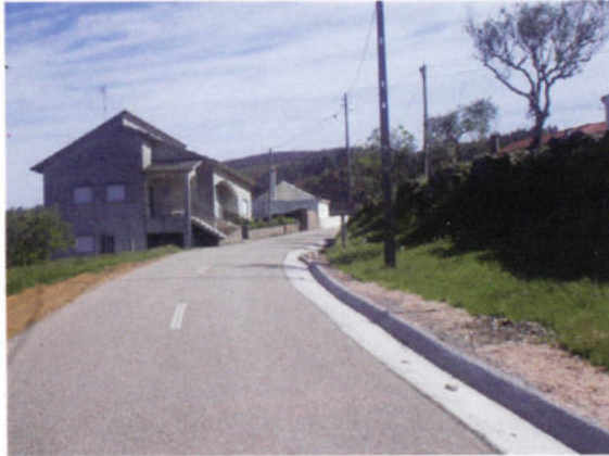
Execução de valeta em Abrunheira - Aguda
