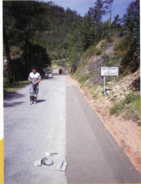
Execução de valeta em Salgueiro da Ribeira - Aguda
