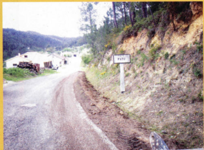
Execução de valeta em Fato - Aguda
