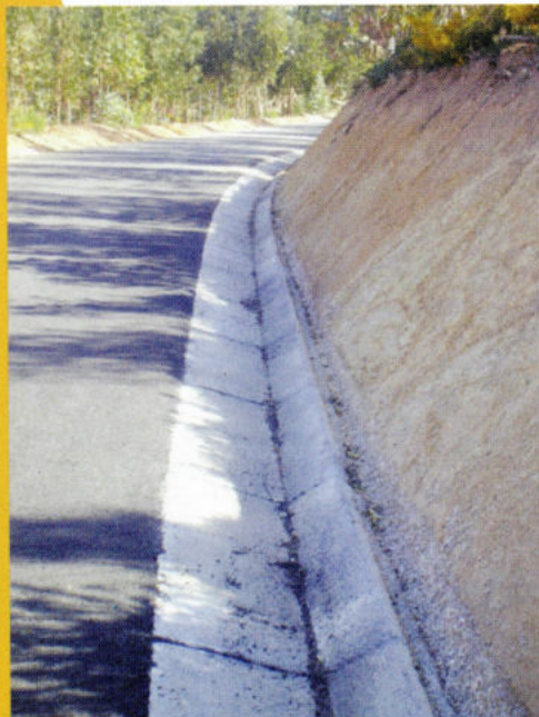
Execução de valeta na freguesia de Bairradas
