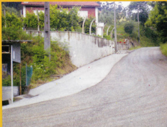
Execução de valeta em Saonda - Aguda
