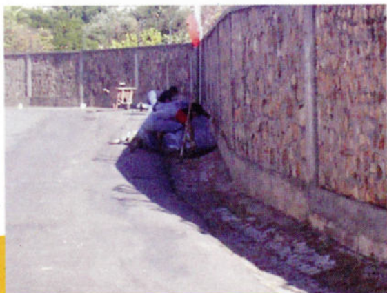
Execução de valeta em Lavandeira - Figueiró dos Vinhos
