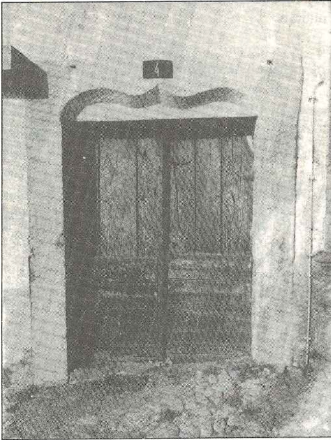
Portal Manuelino (Quelha da Palmeira)
