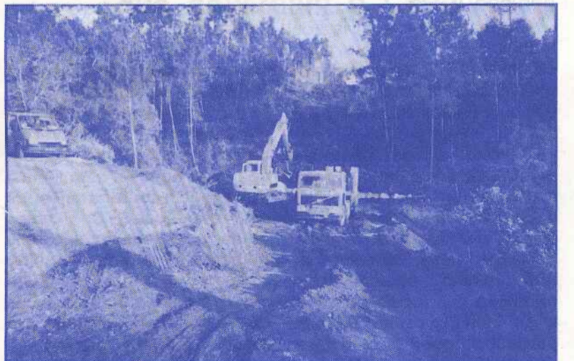
Beneficiação Alargamento e Rectificação da Estrada, entre Almofala e Aguda
