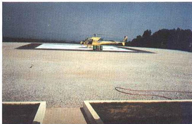
A fim de evitar a projecção de pedras e resíduos, sobretudo aquando da descolagem e aterragem dos helicópteros, foi asfaltada toda a zona envolvente da área de toque, bem como o acesso às instalações, e criado um espaço verde junto à casa do Comando de Operações.
