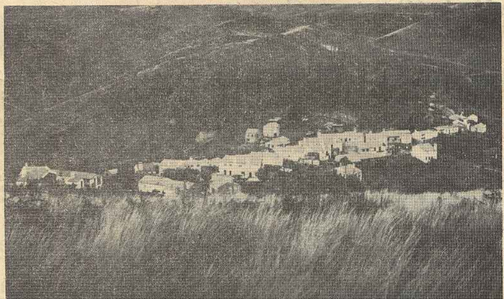
Aspecto da Aldeia do Vale do Rio, após a sua reconstrução. Esta povoação será inaugurada no próximo dia 24 pelo Chefe do Estado, Almirante Américo Tomás
