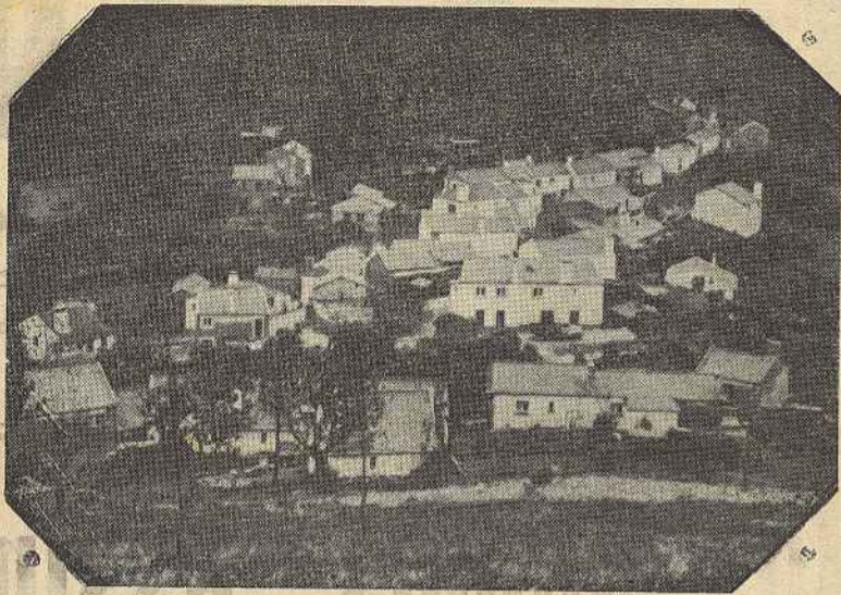
Aspecto actual do Vale do Rio. A inauguração da aldeia reconstruída prevê-se para o princípio do próximo ano.
