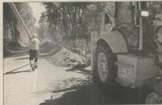
A Câmara Municipal de Figueiró dos Vinhos está a proceder à alteração do sistema de fornecimento público de água às aldeias de Janalvo e Catraia - freguesia de Arega, com a execução de novas infra-estruturas, nomeadamente a construção de uma conduta de 1.800 metros.
