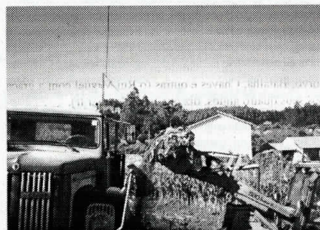
Operação de carga do entulho para ser descarregado no local próprio: a lixeira
