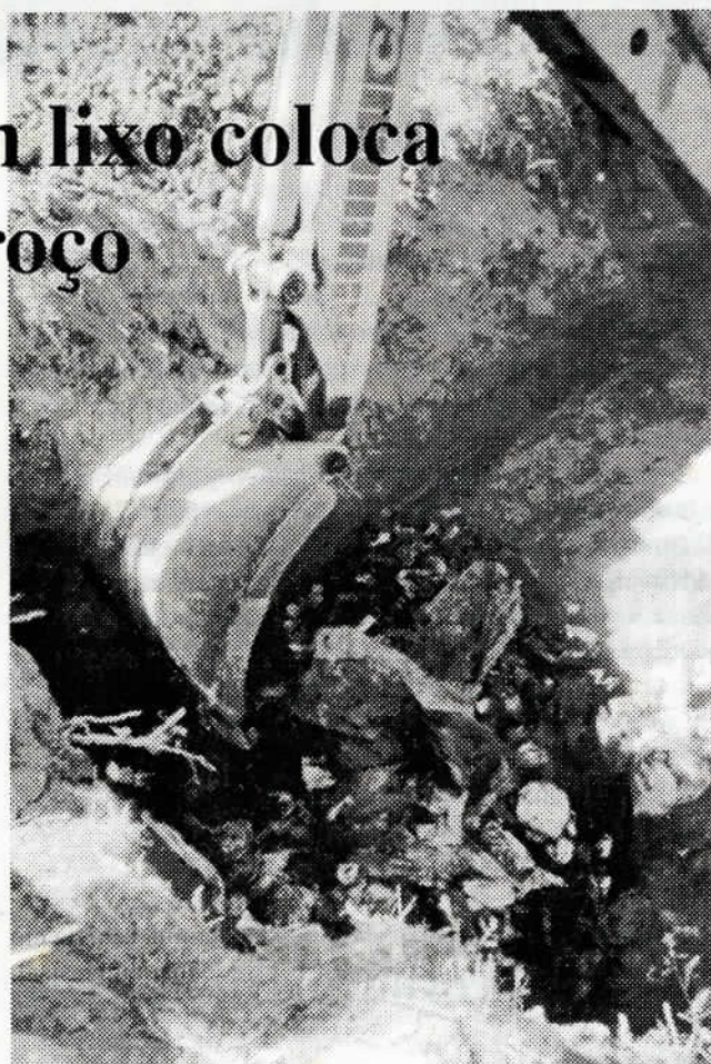
A retroescavadora quando removia o lixo do poço
