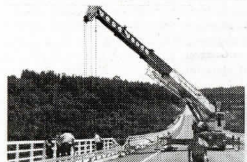
Momento em que o guindaste procedia à remoção do camião na ponte do IC8
