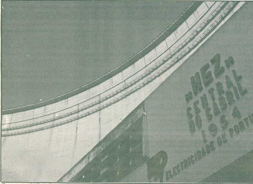
Barragem do Cabril: uma fonte inesgotável para servir Pedrógão.
