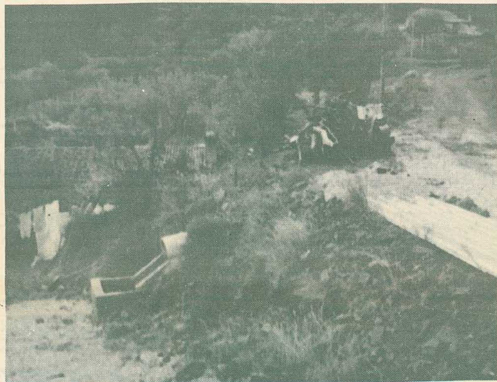
Visível a conduta débil no escoamento das torrentes águas das chuvas
