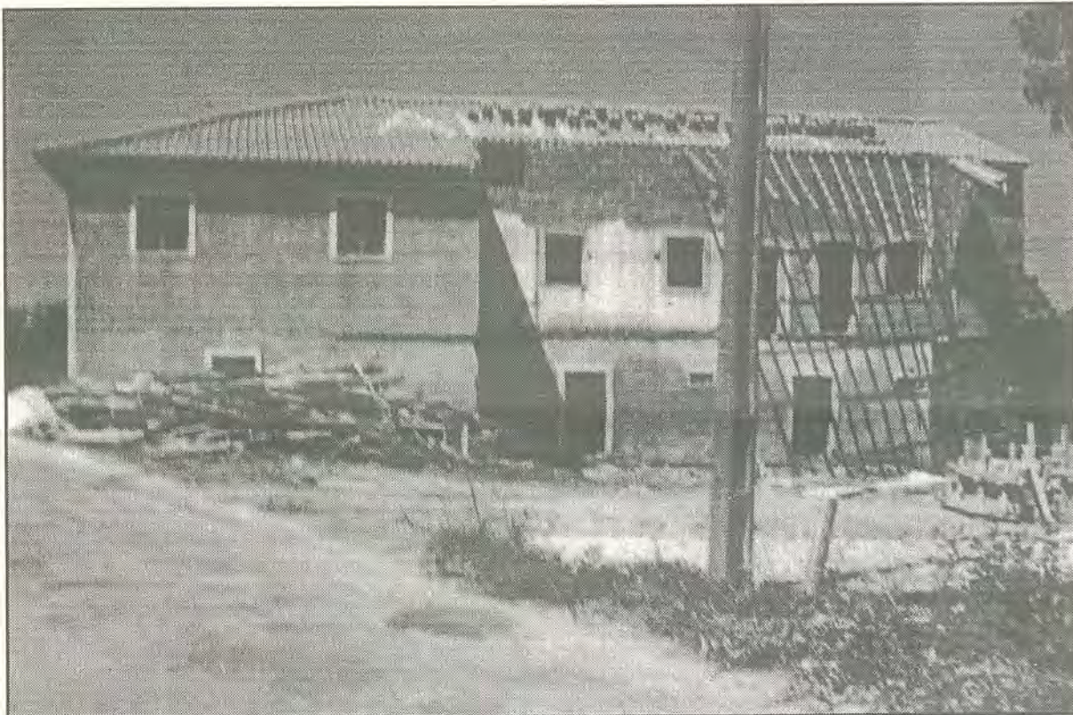
Já está demolida parte da casa para se implantar o anexo, conforme consta do projecto
