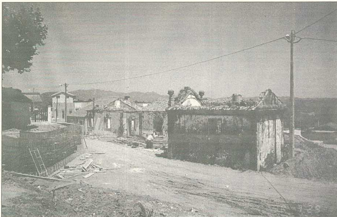
O palácio e Igreja dos Pimentéis Teixeira em Maçãs de D. Maria, em acelerado grau de degradação
