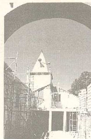
Pormenor do interior, ainda sem o telhado
