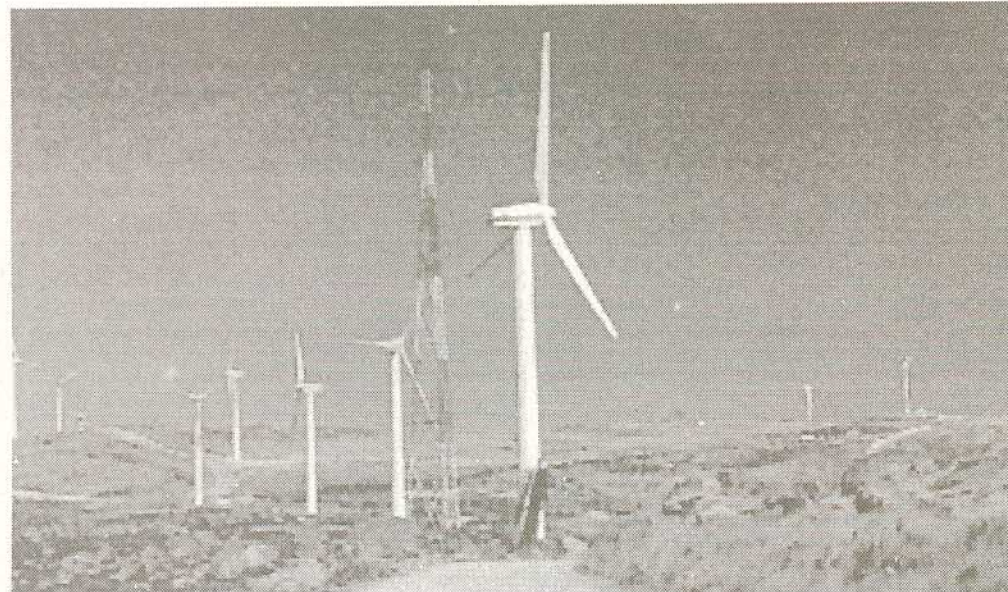
Castanheira irá rentabilizar as potencialidades da sua situação geográfica em energia eólica
