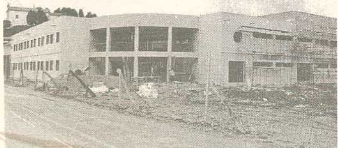
O novo quartel em construção
