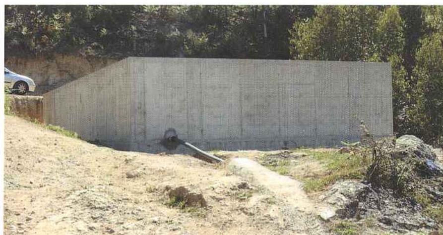
Decorrem as obras de construção do Regadio Tradicional em Enhecamas.
