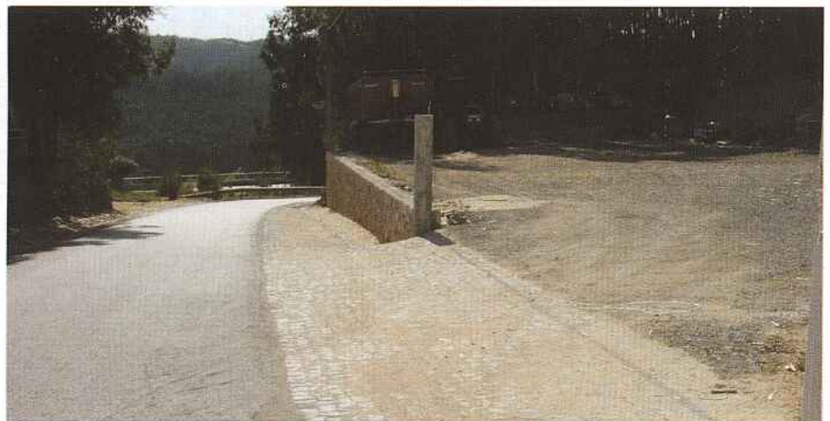
Execução de Calçadas em Ribeiro Travesso.
