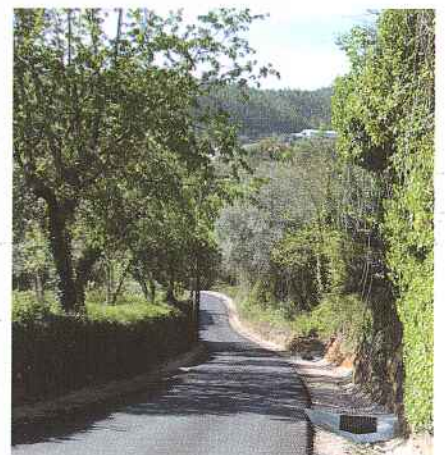
Caminho Agrícola de Telhada. Obra Concluída.
