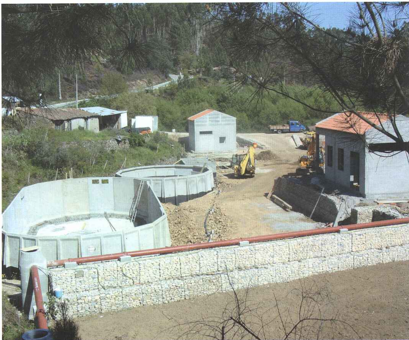
É visível a grande dimensão da nova ETAR de Figueiró dos Vinhos situada na zona extrema do concelho, abaixo da povoação da Cavadinha, cujas obras avançam em bom ritmo de execução.
