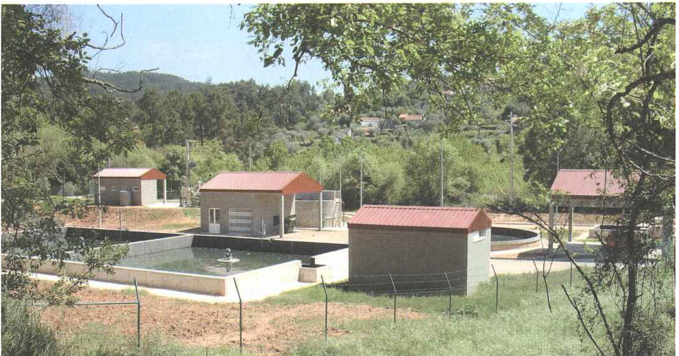
Esgotos em Alta – Construção da ETAR de Vale de Tábuas - Aguda em fase de conclusão.
