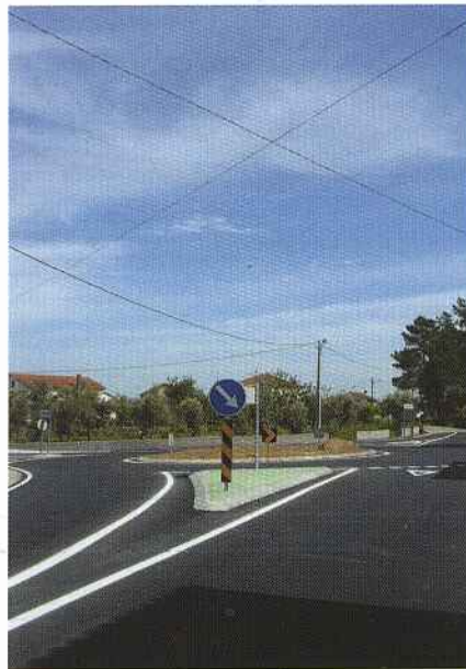
Estão em fase de conclusão os trabalhos de construção da Nova Rotunda em Chãs, freguesia de Bairradas.
