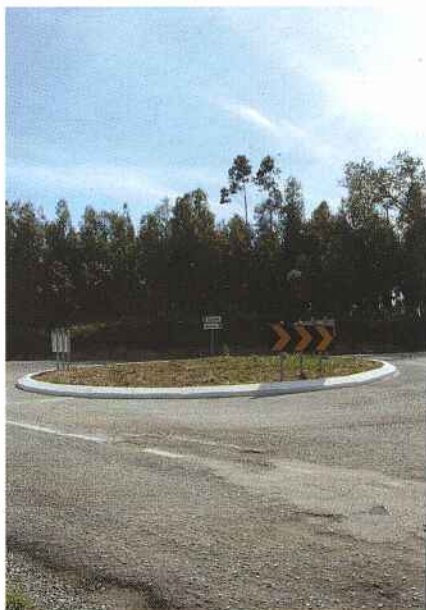
Na Rotunda do Fato, freguesia de Aguda totalmente concluída.
