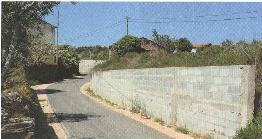
Caminho Agrícola dos Avelais - Arega, obra concluída.
