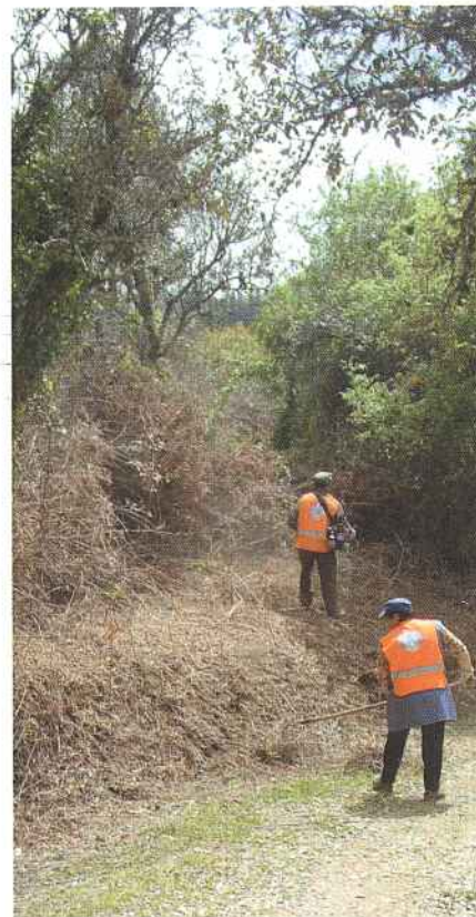
Limpeza de faixas de protecção aos aglomerados populacionais na freguesia de Aguda.
