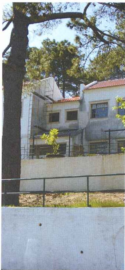
Escola Básica n.º 1 de Figueiró dos Vinhos em beneficiação.
