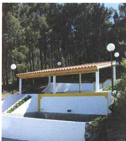
Está concluída a obra de Remodelação da Zona do Fontenário e Lavadouro Público em Pousia - Carapinhal.
