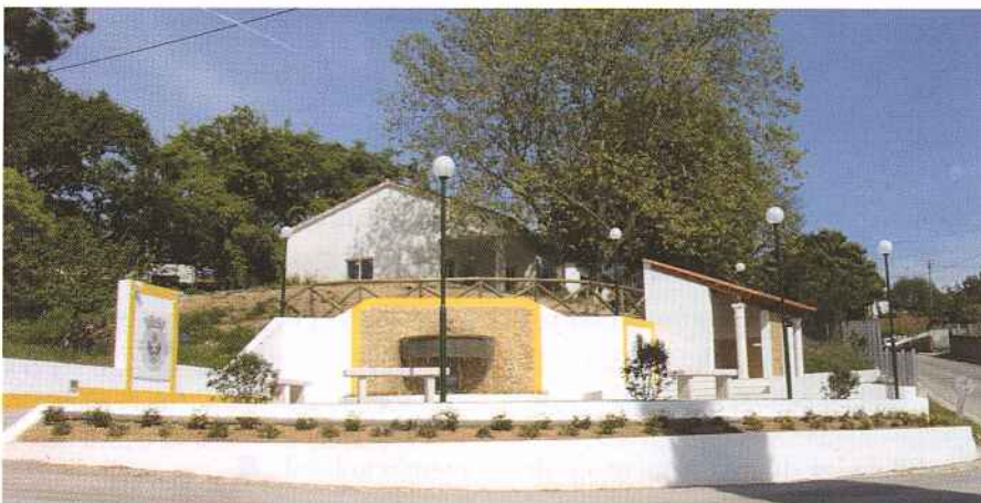
Estão praticamente concluídas as obras de construção da Zona de Lazer de Águda - junto à Escola Primária.
