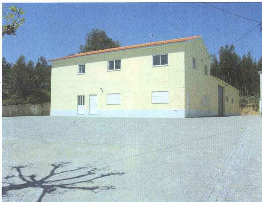
Edifício Sede da Associação Recreativa e Cultural Areguense – ARCA, obra em fase de conclusão apoiada pela Autarquia Municipal.
