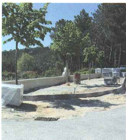
Estão em fase avançada de execução as obras da Zona de Lazer do Colmeal.
