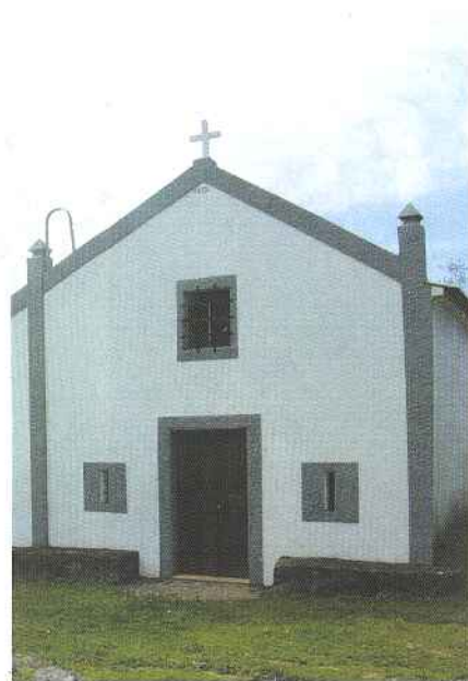
Correspondendo a uma solicitação da Associação Cultural e Recreativa Amigos do Lugar do Douro, a Câmara Municipal apoiou as obras de Beneficiação da Capela do Bom Jesus da Sobreira, peça notável do património figueiroense.
