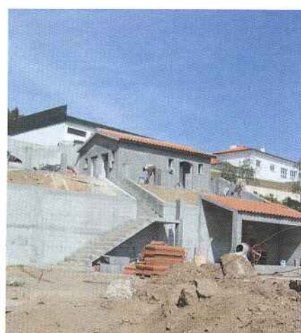
Está em fase avançada de execução a obra de Construção da Zona de Lazer em Aguda
