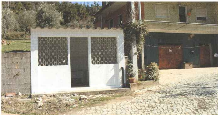
Obras de Beneficiação do Lavadouro em Ribeira do Brás - Arega.
