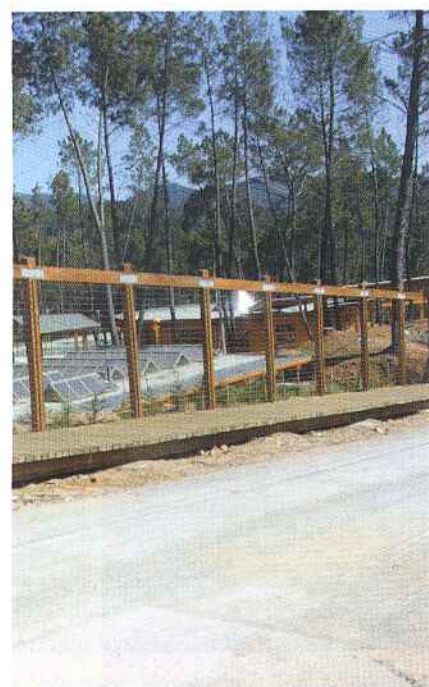
Obras do Passadiço em Foz de Alge, infraestrutura que vem valorizar significativamente aquela zona de aptidão turística.
