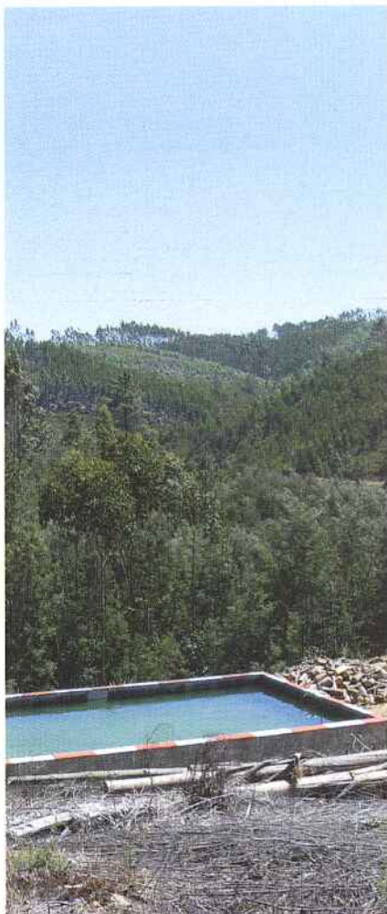
Meios de Prevenção contra incêndios.
