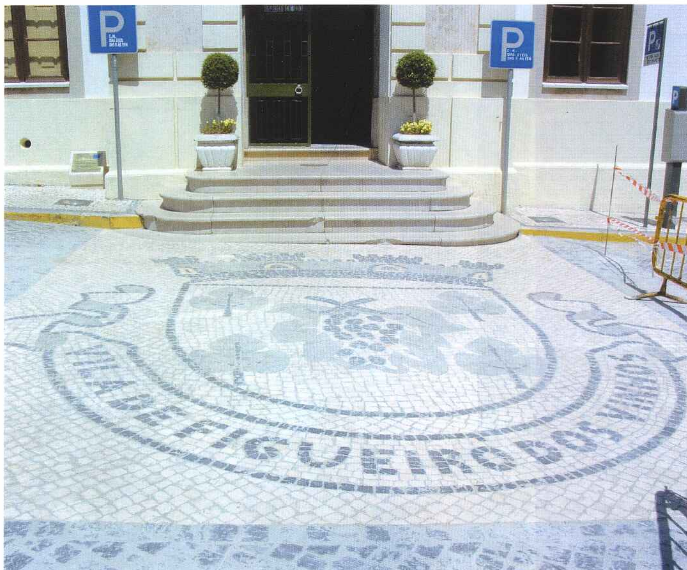
A Praça do Município e Rua da Torre estão a ser beneficiadas com novos pisos em calçada à portuguesa.
