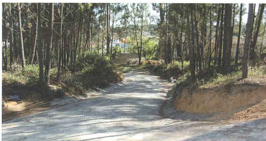
Construção de arruamentos em calçada em Aldeia Cimeira - Bairradas.
