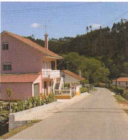
Execução de Calçadas em Várzea Redonda.
