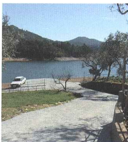
Obras de Beneficiação do piso em Valbom - Arega.
