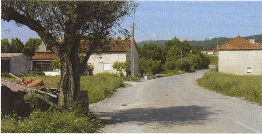
Execução de bermas e valetas em Bairro Industrial - Águda.
