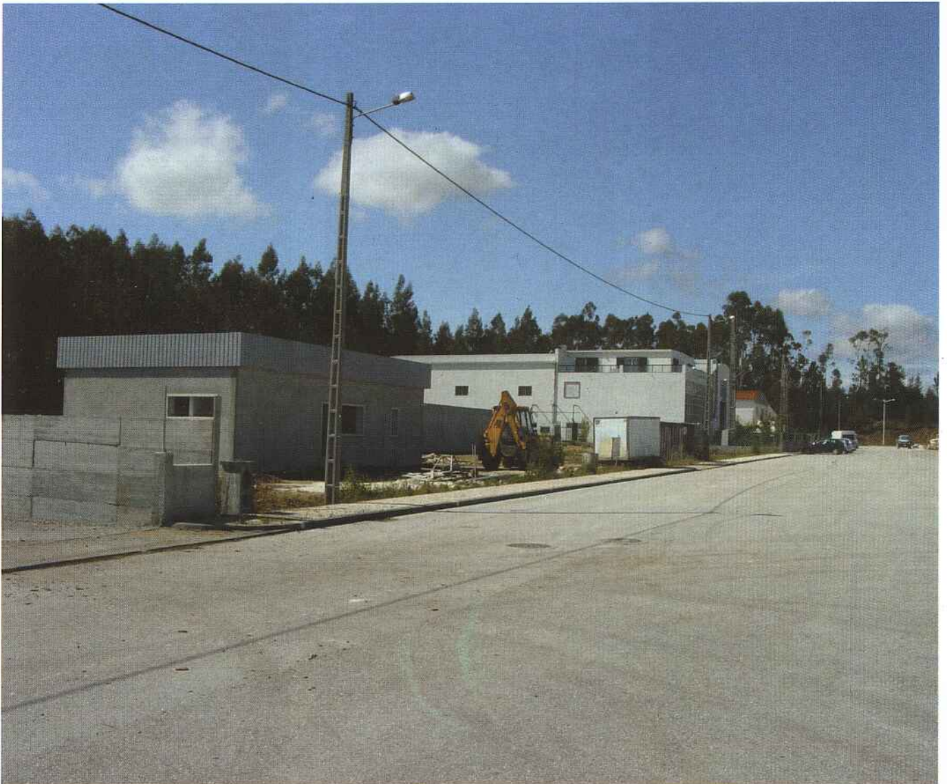
Parque Industrial de Figueiró dos Vinhos. São já visíveis as obras que materializam novos investimentos das Empresas Mofi Carpintaria; Eurovegetal e SicóBetão que virão a criar riqueza e novos postos de trabalho no Concelho.
