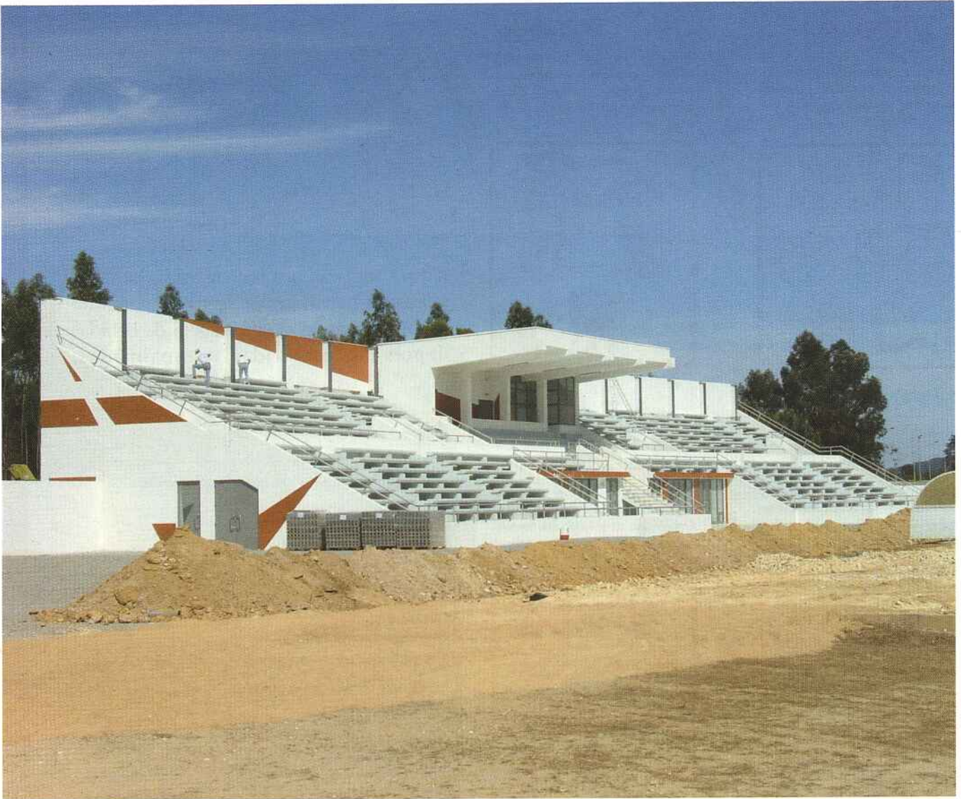
Obras de Arrelvamento do Campo de Futebol e Cobertura das Bancadas do Estádio Municipal Afonso Lacerda.
