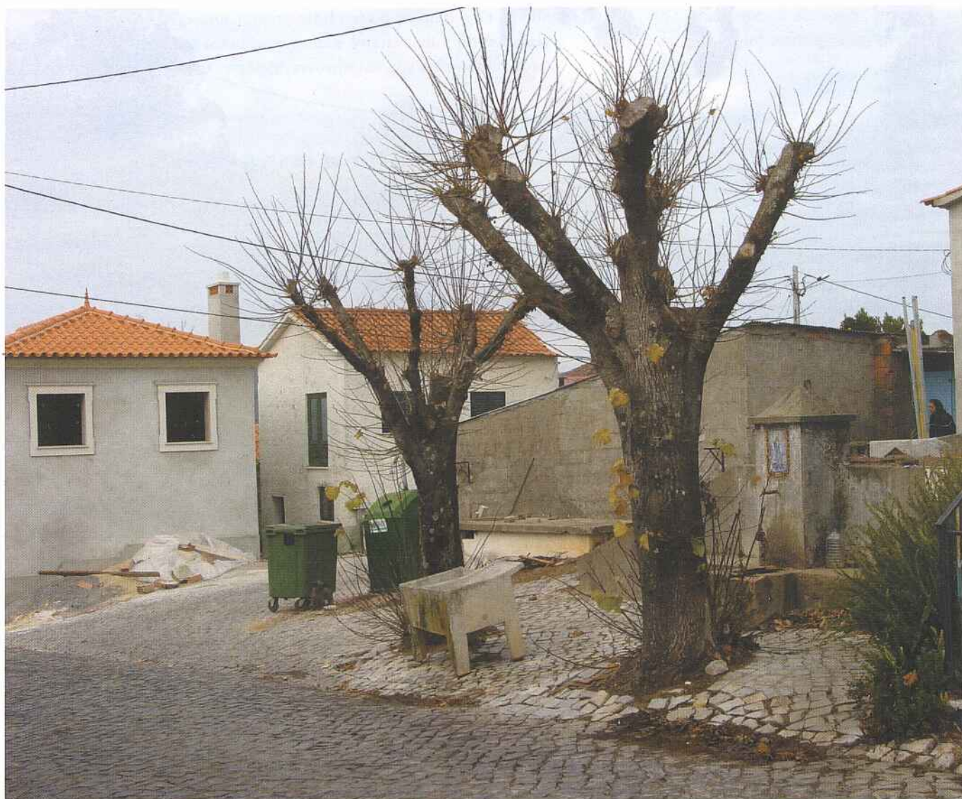
A Construção da Rede de Esgotos da Povoação de Chávelho, obra orçada em 209.470,52 Euros, virá trazer maior qualidade de vida à população daquele lugar da freguesia de Figueiró dos Vinhos.
