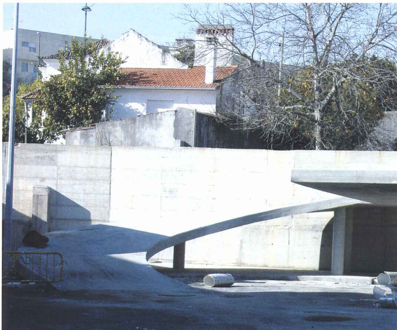
Obra de grande dimensão no tecido urbano da vila, a construção do Parque de Estacionamento junto ao Palácio da Justiça (também em beneficiação) virá aumentar a oferta de estacionamento e facilitar a mobilidade numa zona de Serviços.
