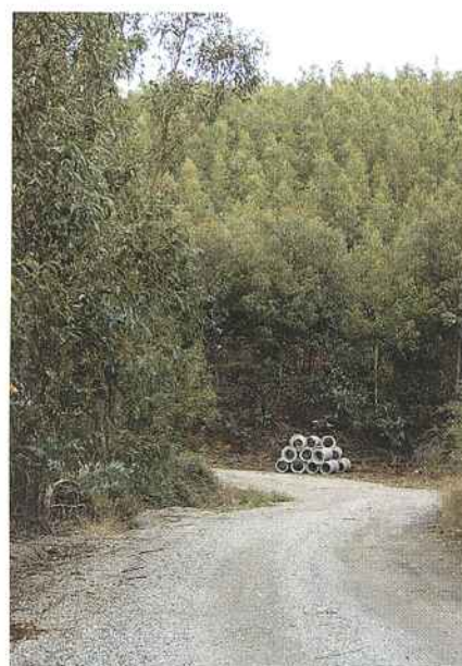
A Câmara Municipal adjudicou definitivamente as obras de Beneficiação de Caminhos e Estradas no Concelho - Freguesias de Aguda, Campelo e Arega, num investimento de cerca de 70.000,00 Euros que permitirá intervir nas estradas: Algecruzamento de Searas; Pé de Janeiro; Acesso junto ao Cemitério de Campelo; Sigoeira-Pereira; Ramal em Almofala de Cima; Casalinho-Estrada de Arega; Ramal dos Brejos e Janalvo-Lameirão.
