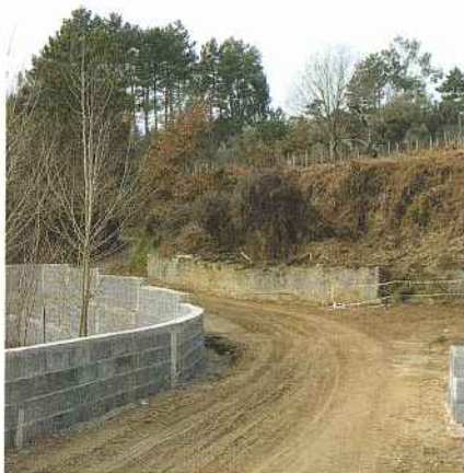
Está em fase de construção o Caminho Agrícola da Telhada.
