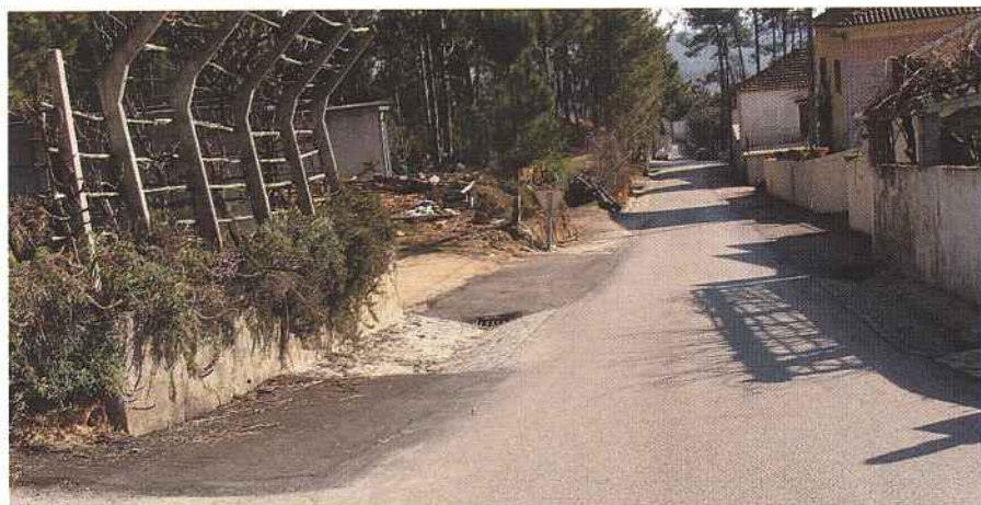
Estão concluídos os trabalhos de Beneficiação e drenagem dos arruamentos em Aldeia Cimeira – Bairradas.
