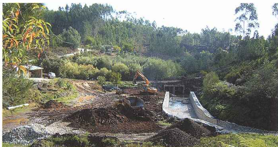
Esgotos em Alta – Construção da ETAR de Figueiró dos Vinhos. Zona Extrema do Concelho, abaixo da povoação da Cavadinha (em construção).
