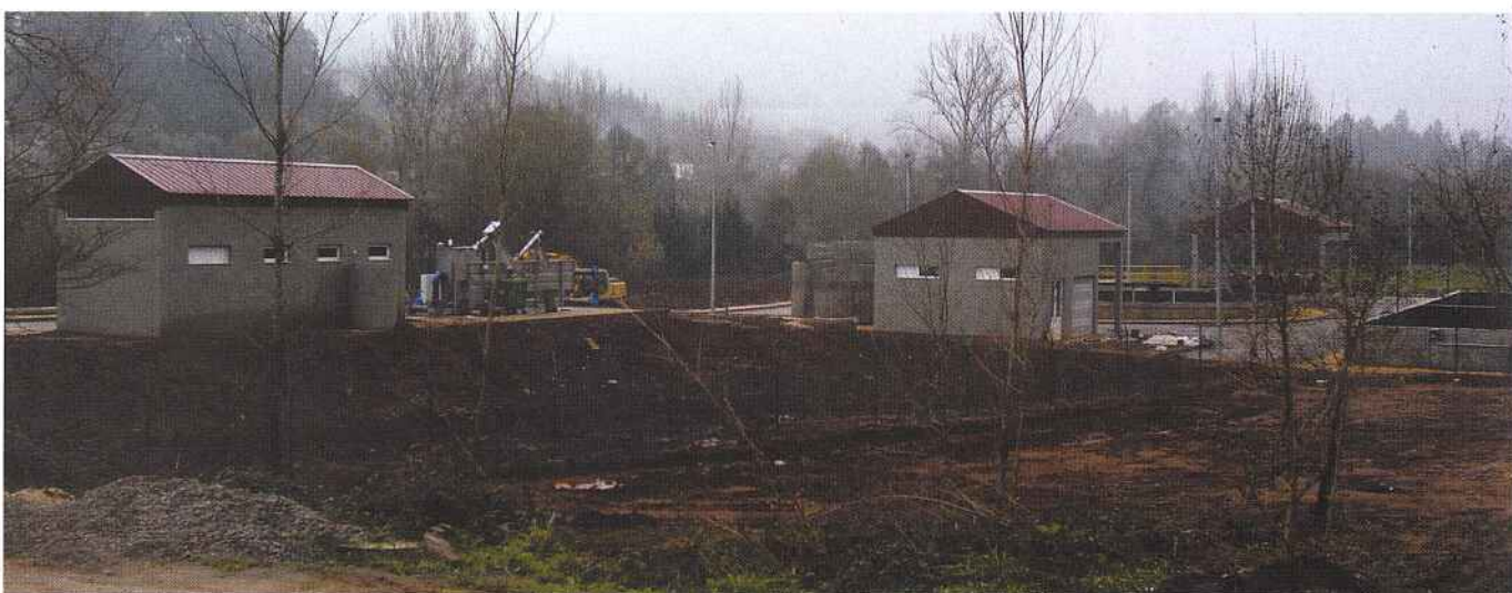
Esgotos em Alta – Construção da ETAR de Vale de Tábuas - Aguda em fase de conclusão.
