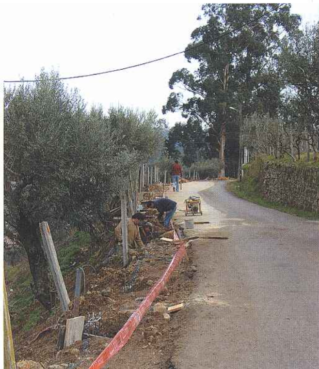
Obras do Passadiço em Foz de Alge, infraestrutura que vem valorizar significativamente aquela zona de aptidão turística.
