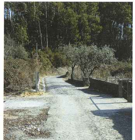
Alargamento da Ponte da Horta do Lagar – Moinho de Cima – Colmeal.
