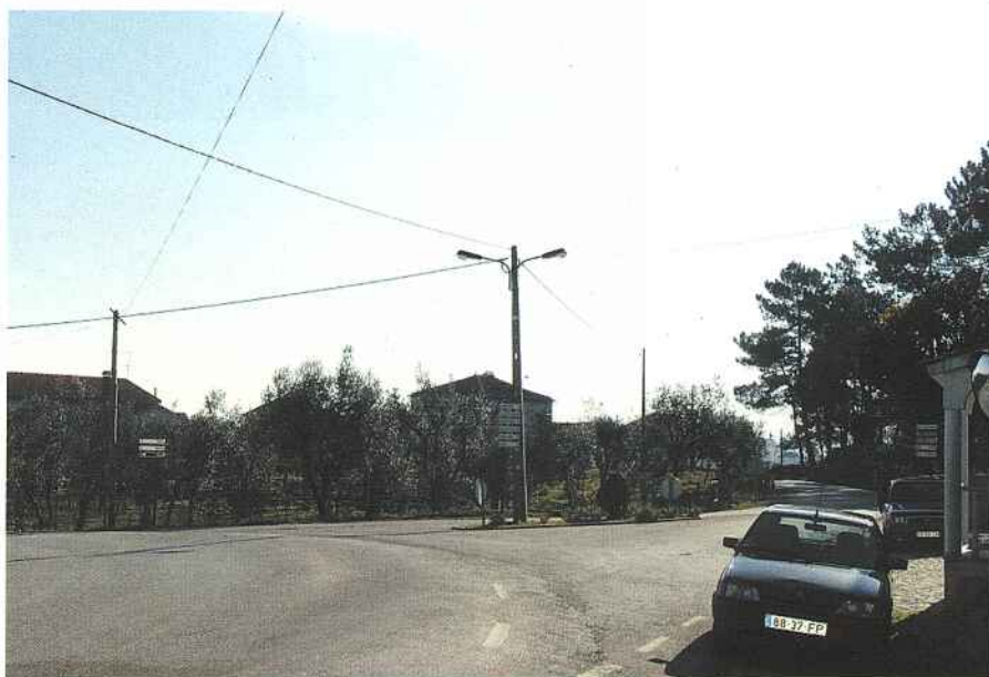
A Câmara Municipal deliberou aprovar o Projecto, Caderno de Encargos e Programa de Concurso relativo à Construção das novas Rotundas em Chãs – Bairradas e Fato – Aguda.
