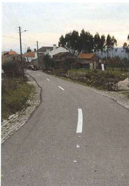
A Câmara Municipal procedeu à pintura do Eixo Viário dos Caminhos Municipais Fato – Salgueiro da Ribeira – Lomba da Casa – Cercal – Abrunheira e Cume na freguesia de Aguda.
