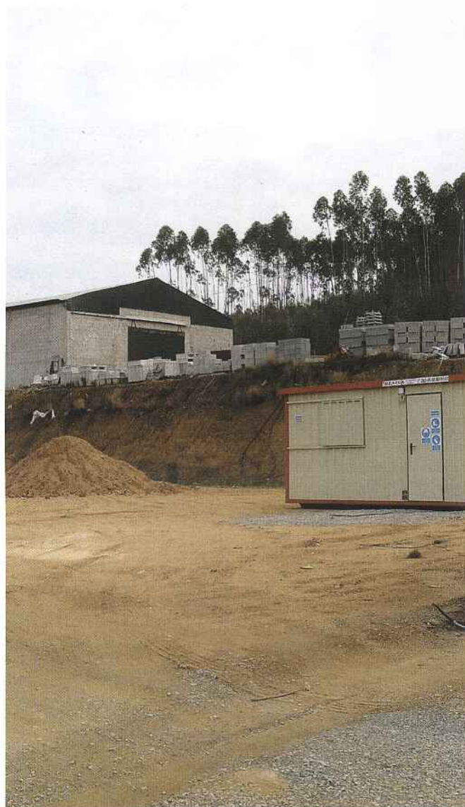
Zona Industrial da Ladeira da Calça. Novas Empresas em fase de instalação.
