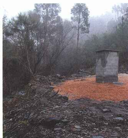
Captação de Água e Estação Elevatória em Pedingote – Alge.
