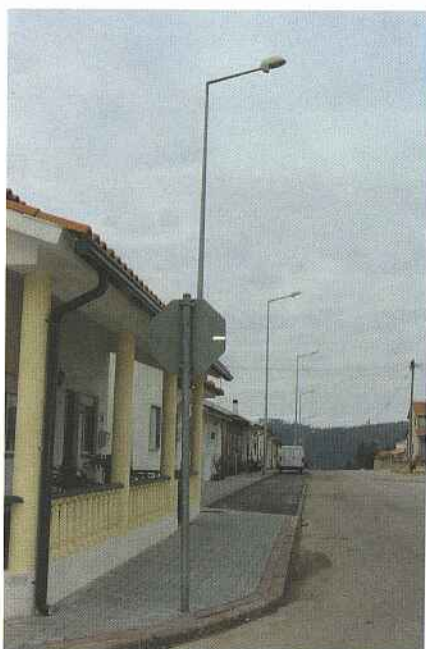
No Bairro Pré-Fabricado estão quase concluídas as obras de Beneficiação de passeios e pavimentos depois de ter sido intervencionada a rede de Iluminação Pública.
