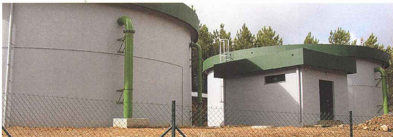
Construção de Novos Depósitos para Abastecimento de Água em Cabeço do Peão.
