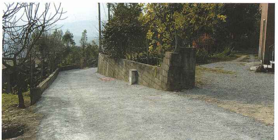
Construção de novos arruamentos e beneficiação de calçadas em Lameirinha, Sigoeira, Moninhos Fundeiros, Cemitério dos Moninhos, Chimpeles, Casal Velho, Valbom e Chãos de Cima.
