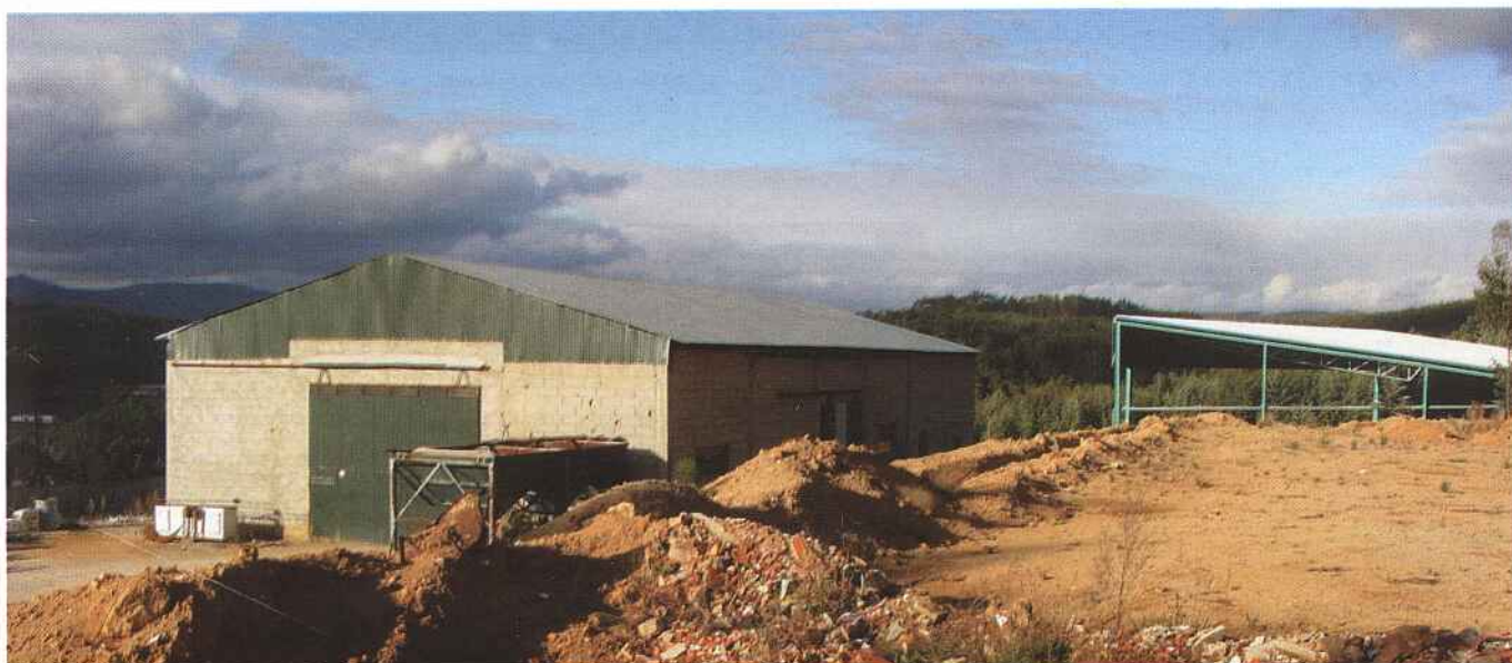
Zona Industrial da Ladeira da Calça. Novas Empresas em fase de instalação.
