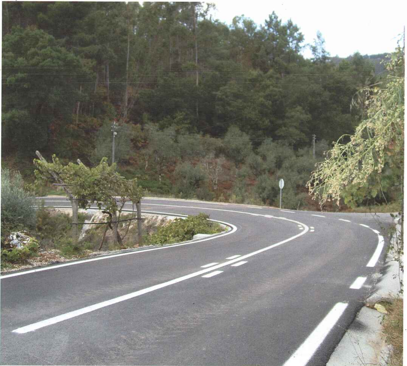
Encontra-se em fase de conclusão a obra de Alargamento, Rectificação e Beneficiação da Estrada Municipal n.º 524 do Nó do IC8 a Chimpeles e da Estrada Municipal 1131 de Chimpeles a Moninhos Cimeiros, investimento de cerca de 661.209,00 Euros.
