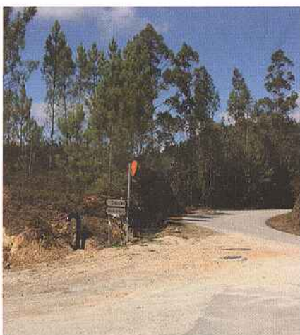
Construção de adutora entre Figueiró dos Vinhos e Arega.
