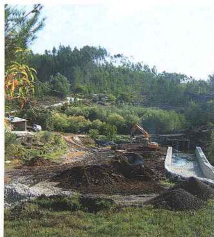
Esgotos em Alta – Construção da ETAR de Figueiró dos Vinhos. Zona Extrema do Concelho, abaixo da povoação da Cavadinha.
