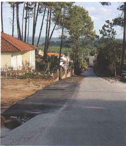
Arruamentos em Aldeia Cimeira - Bairradas.
