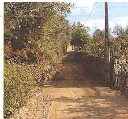
Caminho Agrícola na Telhada em fase de execução.
