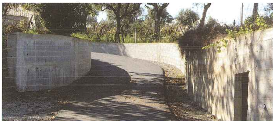
Caminho Agrícola dos Avelais em fase de conclusão.
