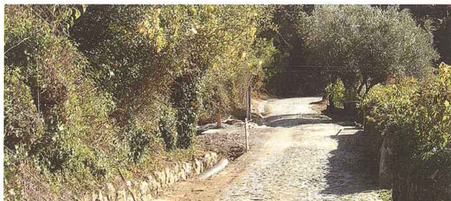
Alargamento da Ponte Horta do Lagar – Moinho de Cima – Colmeal.
