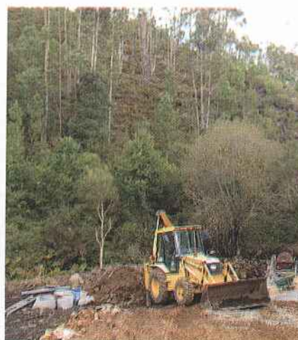
Captação de Água e Estação Elevatória em Pedingote - Alge.
