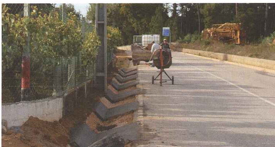
Construção de adutora entre Figueiró dos Vinhos e Bairradas.
