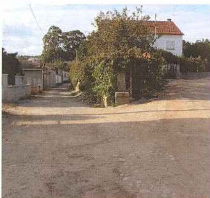
Drenagem de Águas em Ribeira de S. Pedro.
