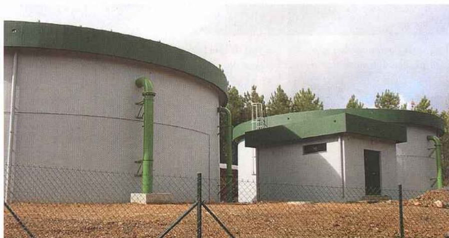
Construção de Novos Depósitos para Abastecimento de Água em Cabeço do Peão.
