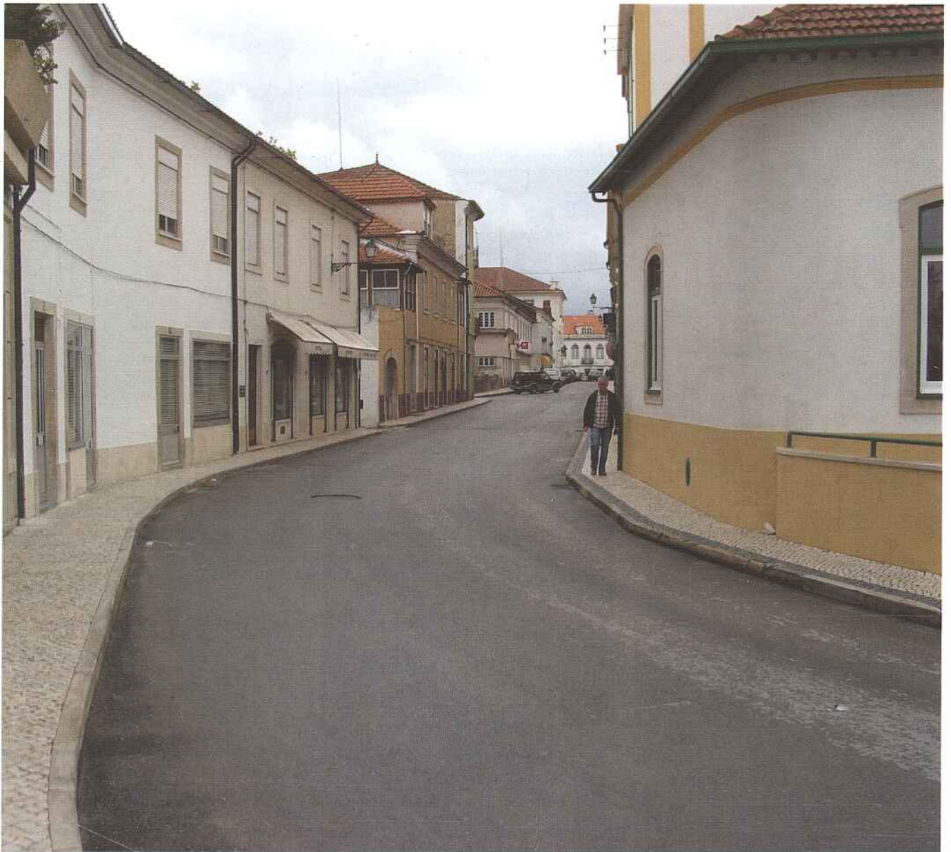
Toda a zona Central da Vila de Figueiró dos Vinhos foi pavimentada de novo depois de obras de drenagem de águas pluviais e fresagem de pisos.
