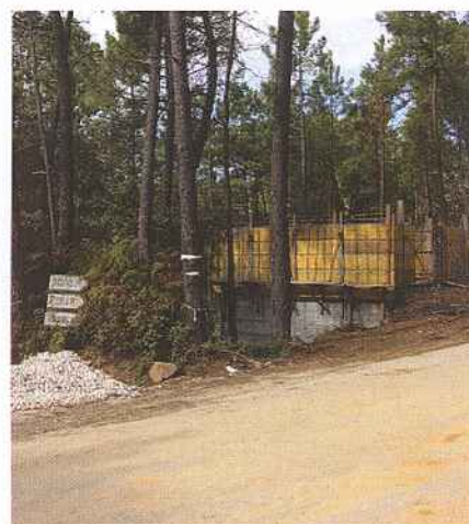
Construção de adutora entre Figueiró dos Vinhos e Campelo.
