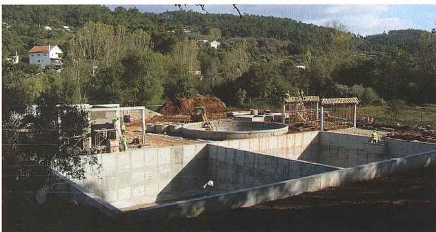
Esgotos em Alta – Construção da ETAR de Vale de Tábuas - Aguda.
