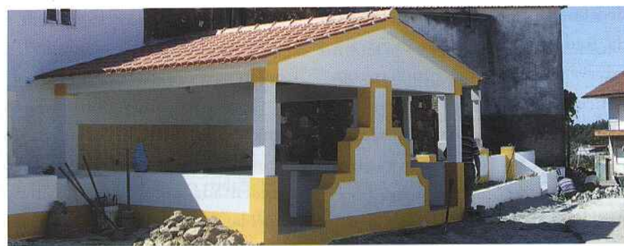
Construção do Lavadouro Público e Zona de Lazer em Aldeia da Cruz vem reabilitar o Largo principal do lugar.
