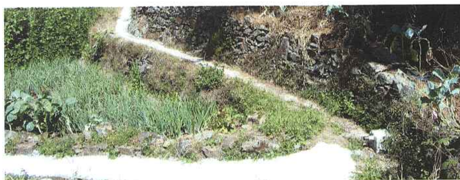
A Câmara Municipal considerou de Interesse Público a construção dos Regadios Tradicionais no Concelho, nomeadamente na Ribeira Velha e Campelo/Campelinho.
