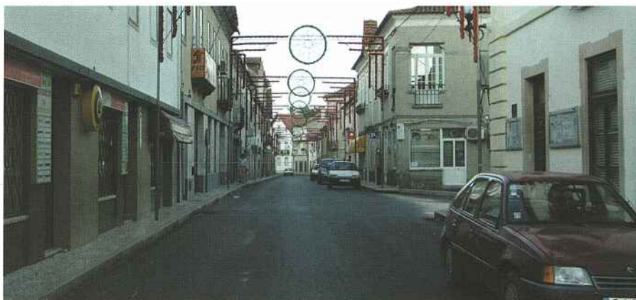
A Rua Dr. Manuel Simões Barreiros foi recentemente intervencionada tendo sido realizados trabalhos de drenagem de águas pluviais, fregagem e aplicação de novo tapete betuminoso.
