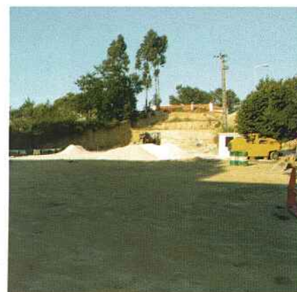
Construção do Parque de Estacionamento na zona do Palácio da Justiça com a capacidade para 124 lugares, criados a partir da demarcação no pavimento e da construção de uma plataforma elevada.
