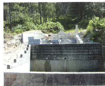
Construção do Lavadouro Público e Fonte da Poisia / Carapinhal.
