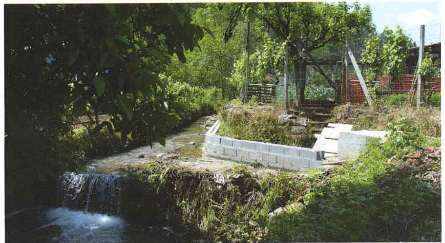
Construção de Açude em Várzea Redonda importante estrutura de apoio à actividade agrícola.
