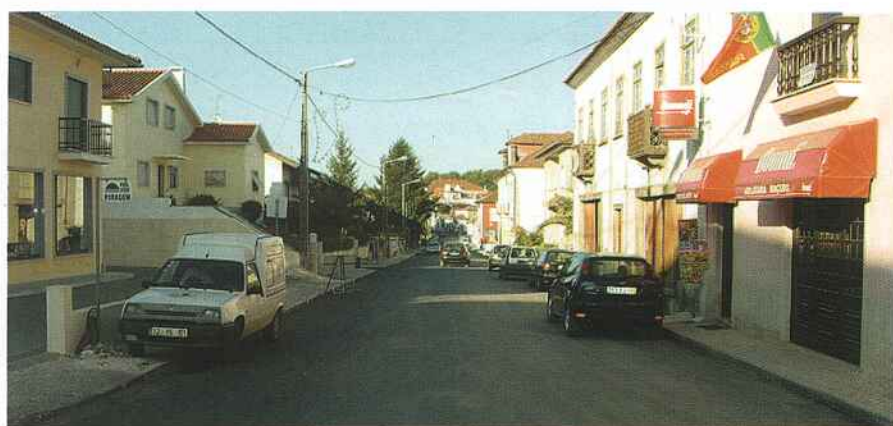
Desenvolvem-se os trabalhos de drenagem de águas pluviais, fregagem e aplicação de novo tapete betuminoso, na Rua Major Neutel de Abreu.
