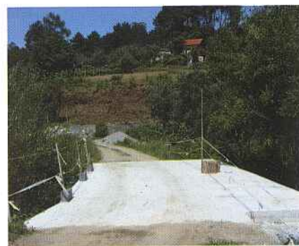
Construção do Caminho Agrícola da Telhada.
