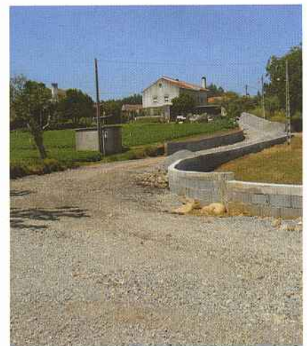
Construção do Caminho Agrícola em Carvalheira-Brejos.
