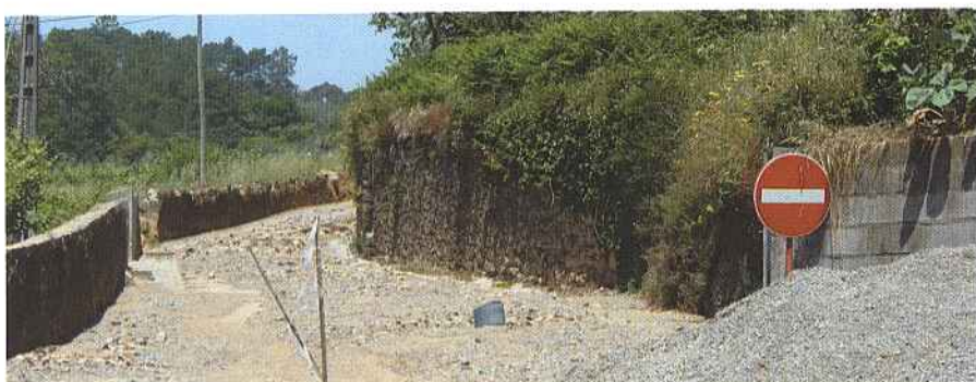
Obras de drenagem de águas na Ribeira de S. Pedro.
