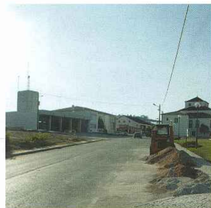
Em fase adiantada de execução continuam os trabalhos de "Beneficiação das Infraestruturas de Iluminação Pública"
