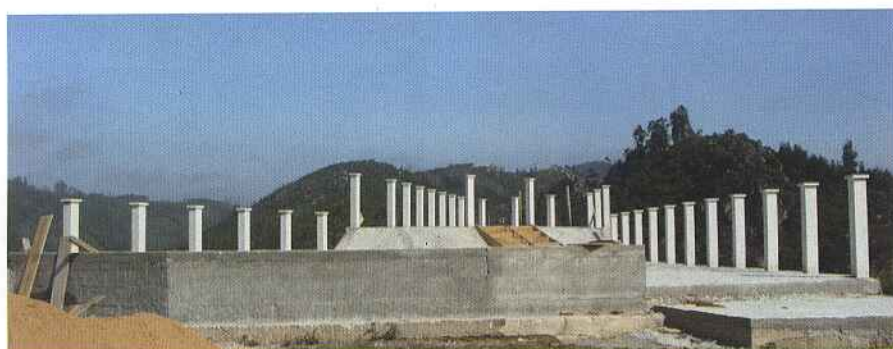
Reabilitação do Miradouro das Fragas de S. Simão, um local emblemático do concelho numa obra de elevado valor de apoio ao Turismo.
