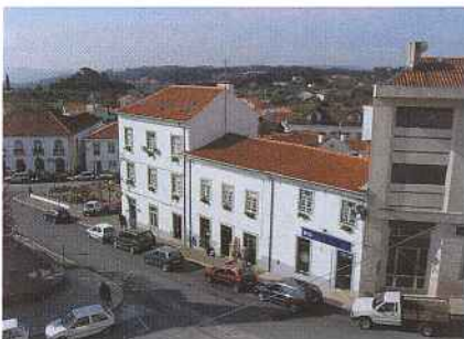
A Rua da Igreja conheceu trabalhos de drenagem e foi beneficiada com um novo piso em betuminoso aumentando a sua funcionalidade.
