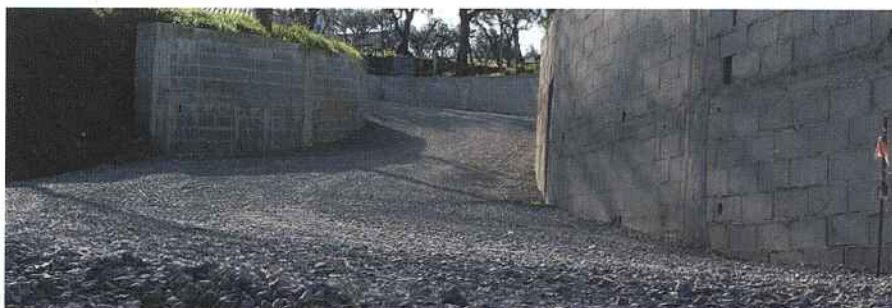
Prosegue a construção do Caminho Agrícola de Avelais.
