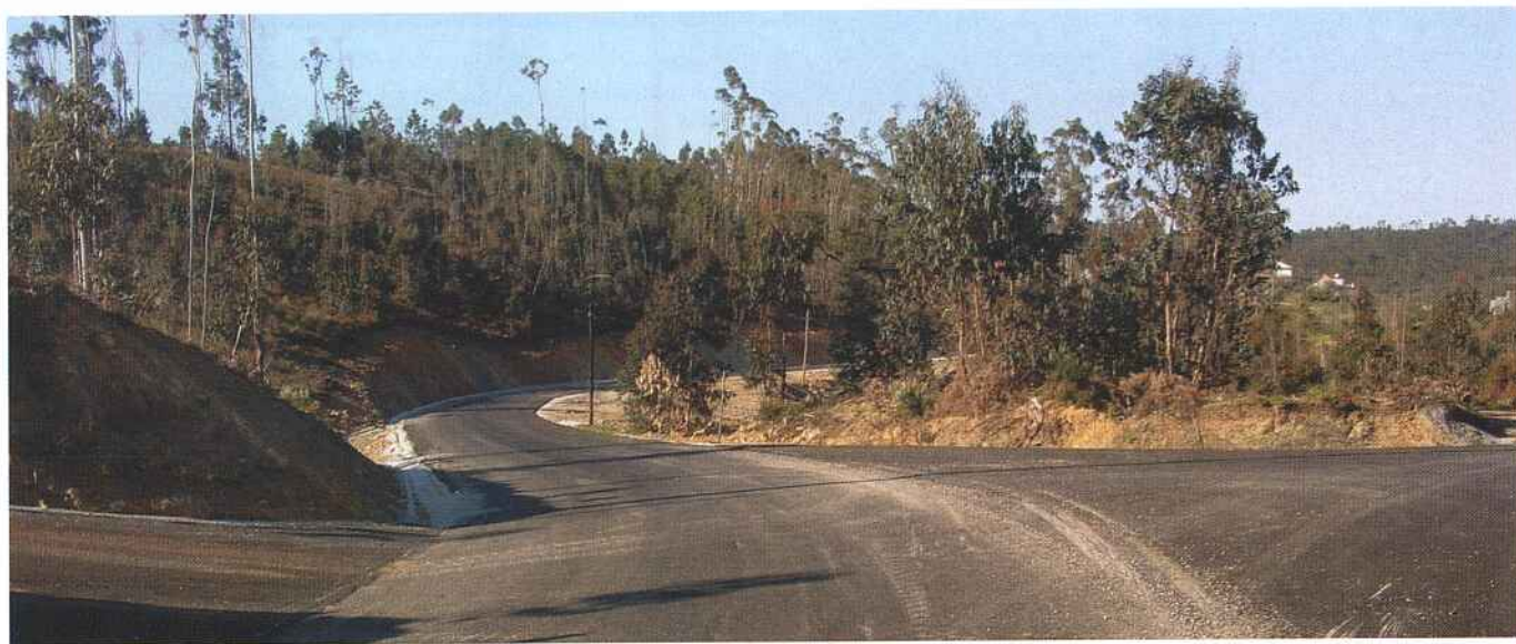
Alargamento, Rectificação e Beneficiação da Estrada Municipal n.º 524 do Nó do IC8 a Chimpeles e da Estrada Municipal 1131 de Chimpeles a Moninhos Cimeiros, investimento de cerca de 661.209,00 Euros, determinante para o desenvolvimento da «Região de Chimpeles e Moninhos». Prevê-se brevemente o final da execução física da obra com a colocação da última camada de betuminoso, colocação de rails e sinalização de trânsito.
