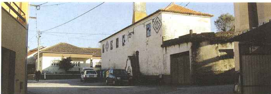
Obras de Iluminação Pública do Núcleo Urbano da Sede de Freguesia de Aguda, complementam outros trabalhos de valorização da Sede de freguesia de Aguda, realizados recentemente pela Câmara Municipal.
