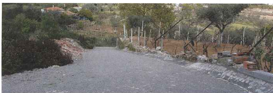
Construção de arruamento em calçada em Casal de Santarém.
