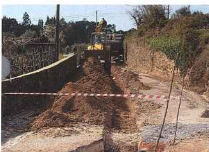
Manilhamento e drenagem de águas pluviais em Ribeira de S. Pedro.
