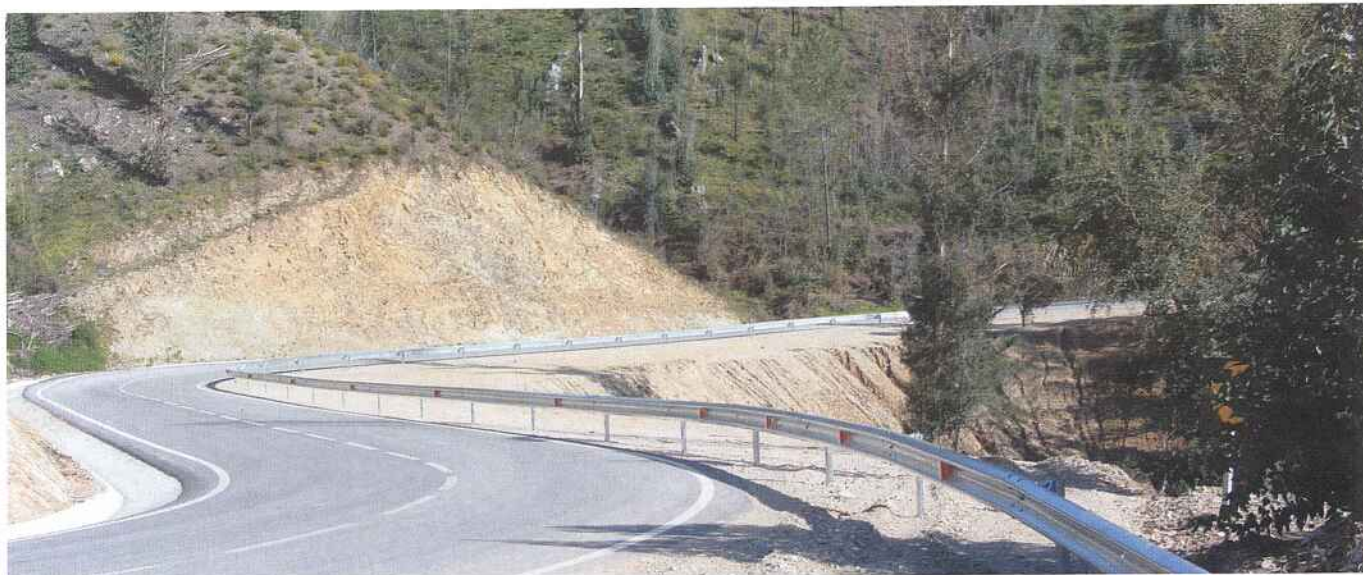
Alargamento, Rectificação e Beneficiação do Caminho Municipal n.º 1142 – Enhecamas a Foz de Alge –, um investimento de mais de 963.311,00 Euros, que vem melhorar substancialmente as acessibilidades a uma zona de grande vocação turística. Obra em fase de acabamentos com a colocação de rails e sinalização de trânsito.
