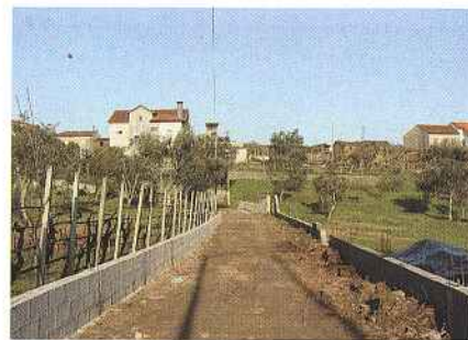
Execução de Manilhamento em Aldeia da Cruz beneficiando uma zona de construção de novas moradias, acompanhando a Autarquia o desenvolvimento local.
