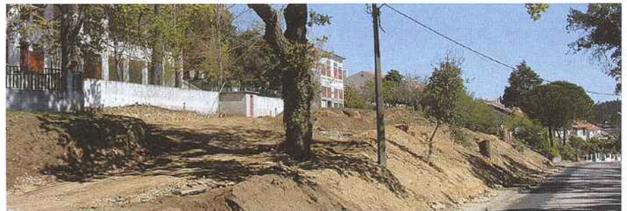
Desenvolvem-se as obras de qualificação paisagística no campo da Mocidade, espaço público ao qual se pretende conferir uma nova funcionalidade, convertendo-o em zona de convívio e lazer. Será criada uma nova via de acesso, estacionamento, passeios, instalação de mobiliário urbano e iluminação, bem como instalação de sistema de rega e plantação de árvores.
