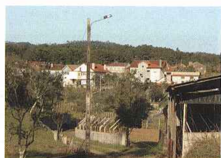
Ramal de Iluminação em Aldeia da Cruz numa zona central do lugar que a Autarquia dotará de um novo piso em betuminoso.
