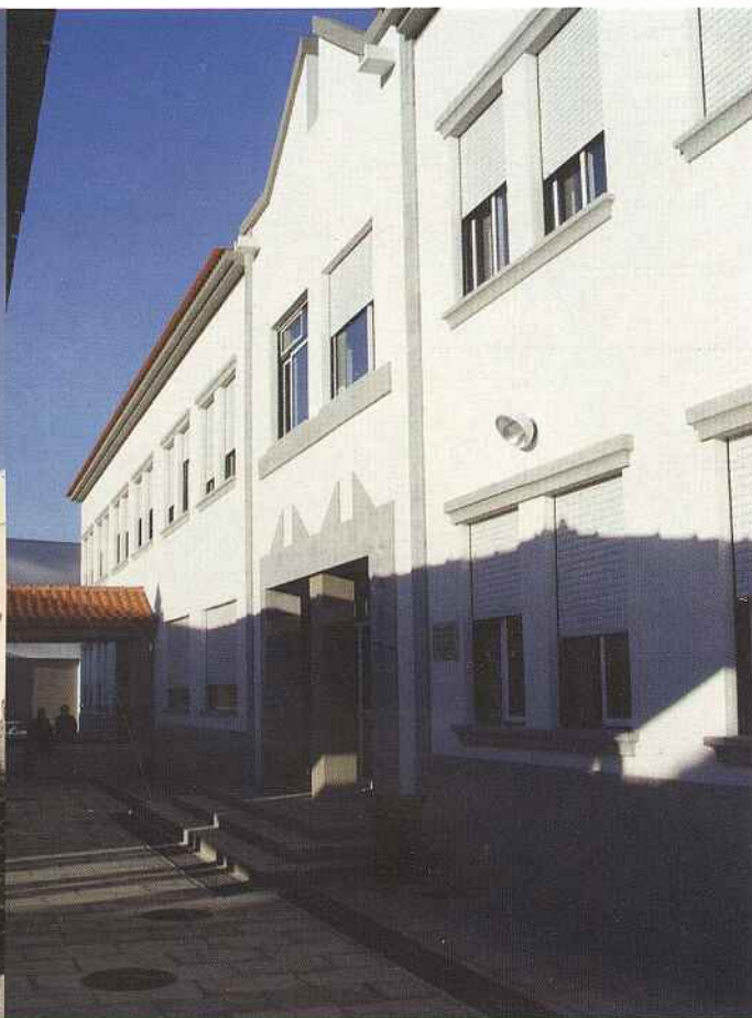
Novas Instalações da Escola Básica n.º 2 de Figueiró dos Vinhos
