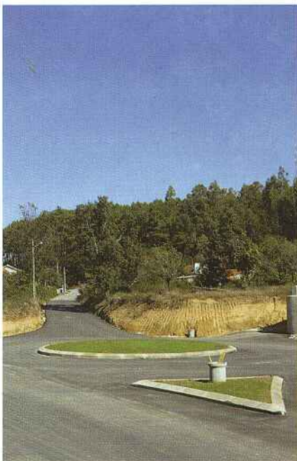
Construção da Rotunda na Avenida Mãre de Deus permitirá disciplinar o trânsito, consistindo a intervenção na construção de muros de suporte, pavimentação do arruamento, construção de passeios, instalação de sinalização e beneficiação da iluminação pública.
