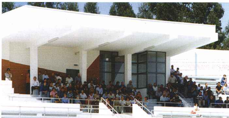
Nova Bancada do Parque Desportivo de Figueiró dos Vinhos.
