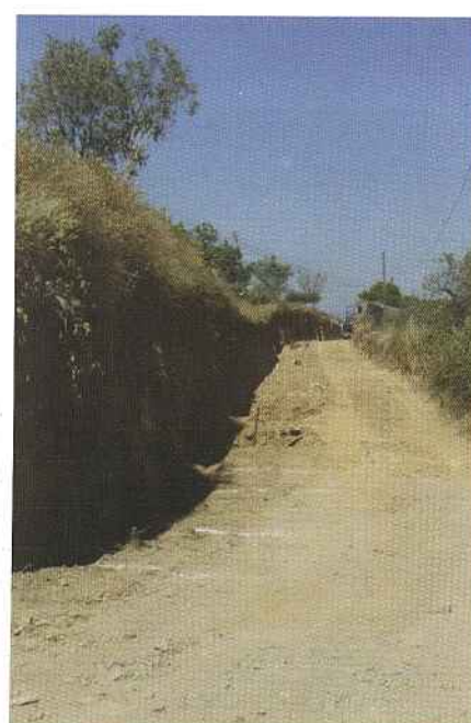
A Câmara Municipal continua a desenvolver os Trabalhos de Construção dos Caminhos Agrícolas de Avelais e Brejo – Avelais, procurando potenciar o interesse agrícola daqueles zonas e facilitar a circulação destas povoações.
