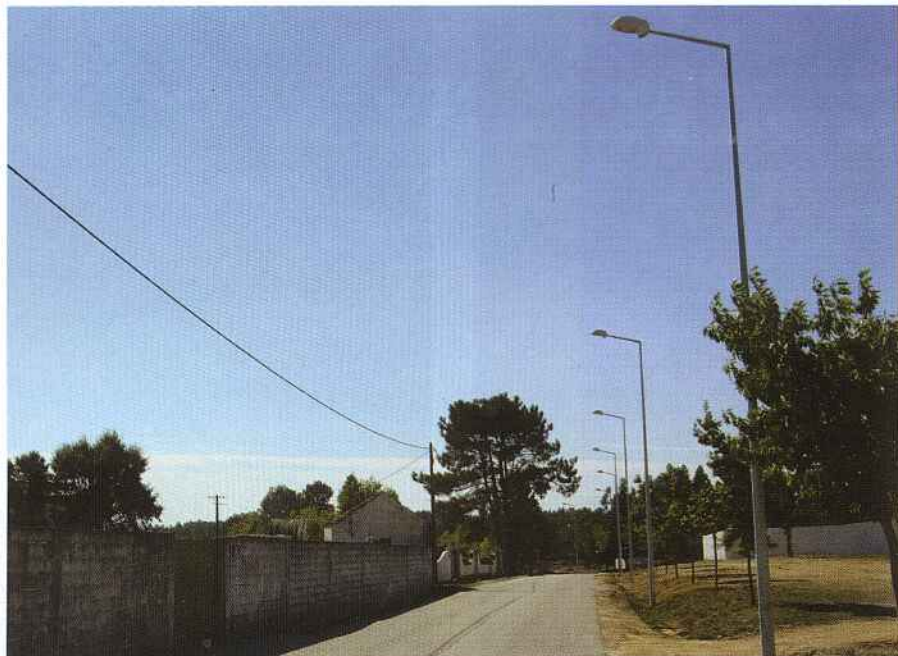
Prosseguem as intervenções referentes à «Beneficiação das Infra-estruturas de Iluminação Pública» que permitirão dotar de moderna iluminação as seguintes artérias: Rua Major Neutel de Abreu, Avenida do Campo de Futebol, Avenida Heróis do Ultramar, Rua da Escola Secundária, Bairro Pré-Fabricado, Avenida José Malhoa, Bairro Teófilo Braga, Rua da Misericórdia, Avenida Dr. Francisco Sá Carneiro, Rua dos Bombeiros Voluntários e Rua Comendador Araújo Lacerda.
