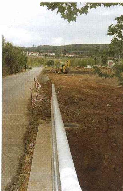
Construção de Valetas e drenagem, em Bairro Industrial, freguesia de Aguda, que contribuirá para melhorar as condições na estrada recentemente beneficiada.
