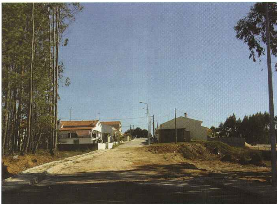
Decorrem a bom ritmo os trabalhos de requalificação do Bairro Pré-Fabricado, com a pavimentação em Calçada miúda dos passeios, iluminação, e ligação ao loteamento e à ex. Estrada Nacional 237, permitindo criar nove lotes para a construção em terrenos camarários.
