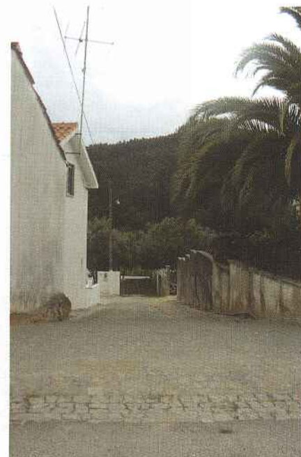
Arruamento em Calçada construído em Aldeia de Ana de Aviz que dá continuidade ao permanente trabalho de valorização dos lugares do concelho. A Autarquia tem desenvolvido trabalhos de construção de novos calcetamentos e reparação de outros, em lugares como Aldeia de Ana de Aviz, Foz de Alge, Aldeia da Cruz, Ribeira de S. Pedro, Cabeças e Chimpeles.
