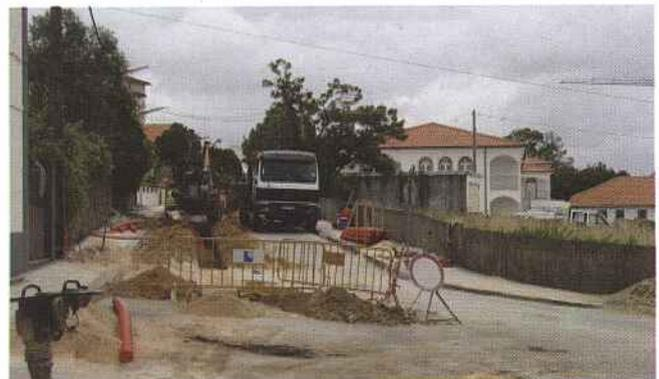
Na zona da *Avenida Dr. Francisco Sá Carneiro* para além da fresagem e substituição do pavimento executaram-se obras de drenagem de águas pluviais, havendo ainda intervenção ao nível da beneficiação das Infra-estruturas de Iluminação Pública.
