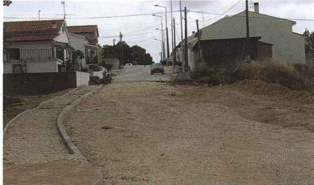
A intervenção consiste na pavimentação em calçada miúda dos passeios do Bairro Pré-Fabricado, iluminação e ligação do referido Bairro ao Loteamento e à EN 237, permitindo ainda criar nove novos lotes para a construção em terrenos camarários.
