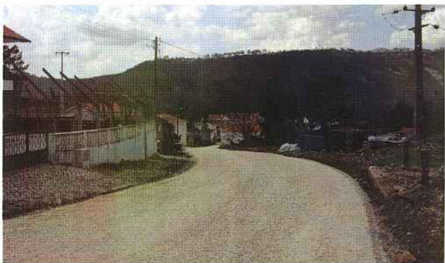
Alargamento, Rectificação e Beneficiação da Estrada Municipal 524 do Nó do ICS a Chímpeles, e da Estrada Municipal 1131 de Chímpeles a Moninhos Cimeiros, investimento de cerca de 661.209.00 euros. Permitirá diminuir a distância à sede de Concelho e ao ICS, traduzindo-se na melhoria da qualidade de vida das populações que abrange.
