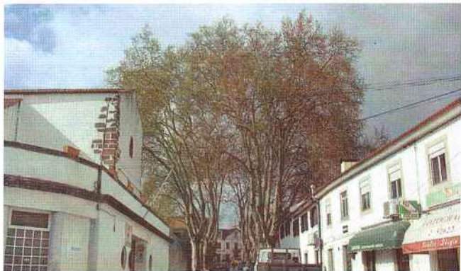
A sala de visitas de Figueiró dos Vinhos será beneficiada com novo piso de revestimento em betão betuminoso, instalação de novo mobiliário urbano (bancos, papeliras), bem como painéis informativos, continuando o crescente cuidado no tratamento e manutenção dos Jardins.
