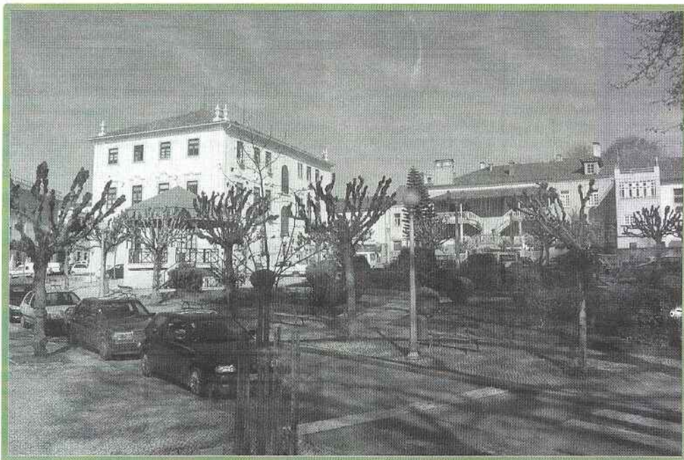
Edifício dos Paços do Concelho na actualidade
