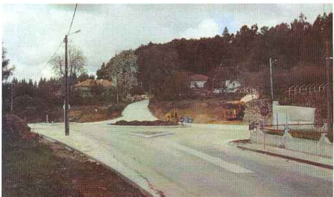
A Construção da Rotunda na Avenida Madre de Deus justifica-se pela necessidade de disciplinar o trânsito no cruzamento desta Avenida, com a Rua de S. Sebastião, com o acesso ao Chão da Amoreira e Ribeiro Traverso. A intervenção consiste na construção de muros de suporte em alvenaria, pavimentação do arruamento, passeios em calçada miúda e instalação de sinalização adequada e beneficiação da Iluminação pública.
