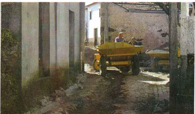
As obras de reforço de abastecimento de água à Ribeira Velha , permitirão àquela população o acesso àquele bem precioso com mais qualidade.
