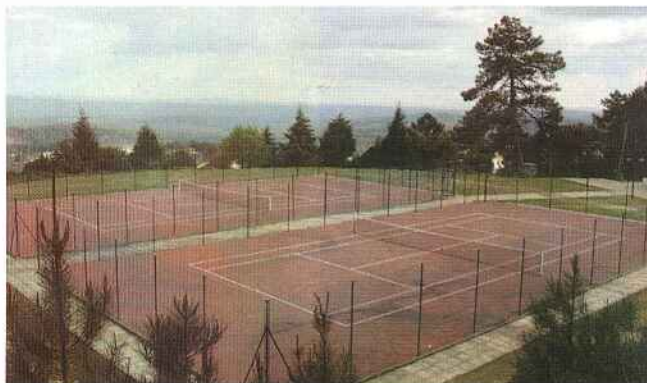
Os Campos de Ténis situados na zona do Cabeço do Peão serão dotados de instalações de utilização de energia eléctrica, permitindo a sua iluminação.
