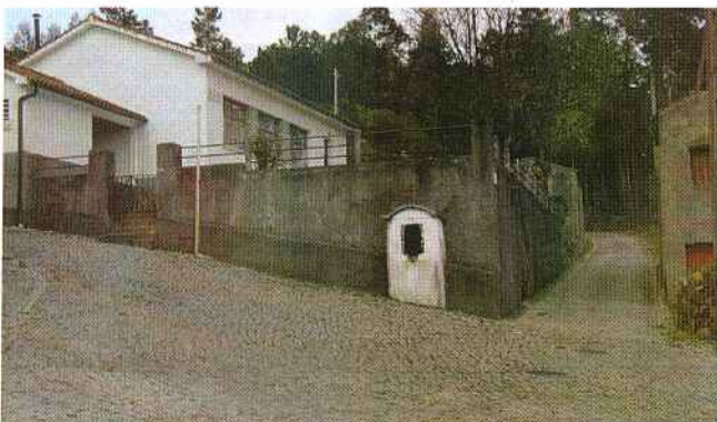
O programa de limpezas de ruas e valetas em diversos lugares do concelho prossegue a bom ritmo, tendo sido já intervencionados os lugares de Chãos, Chávelho, Telhada, Ribeira de S. Pedro, Porto Douro, Forno Telheiro, Vale do Rio, Castanheira de Figueiró, Aldeia da Cruz, Aldeia Ana de Avis e Douro.
