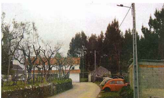
Respondendo às solicitações das populações a Câmara Municipal tem proporcionado o prolongamento dos Ramais de Iluminação Pública em diversos lugares do concelho nomeadamente, em Bairrão, Aldeia da Cruz e Bairradas.
