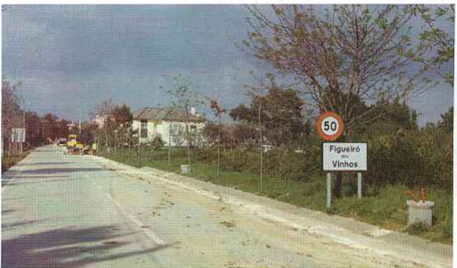
Na zona da Avenida Heróis do Ultramar são visíveis obras de beneficiação das Infra-estruturas de Iluminação Pública.
