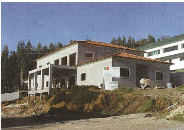
Obras das Valências de Apoio Domiciliário e Centro de Convívio de Aguda
