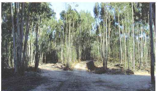
Beneficiação da EM 1145 do Vale do Prado a Foz de Alge
