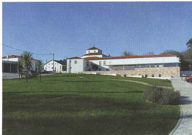
Exterior Biblioteca Municipal
