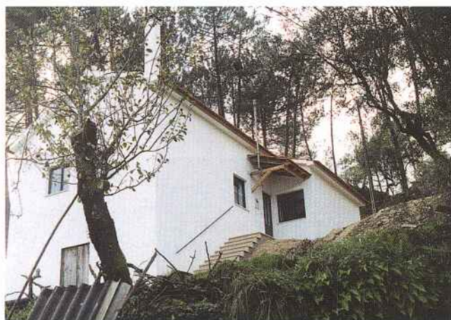
Beneficiação de habitação degradada no âmbito do Projecto de Luta Contra a Pobreza
