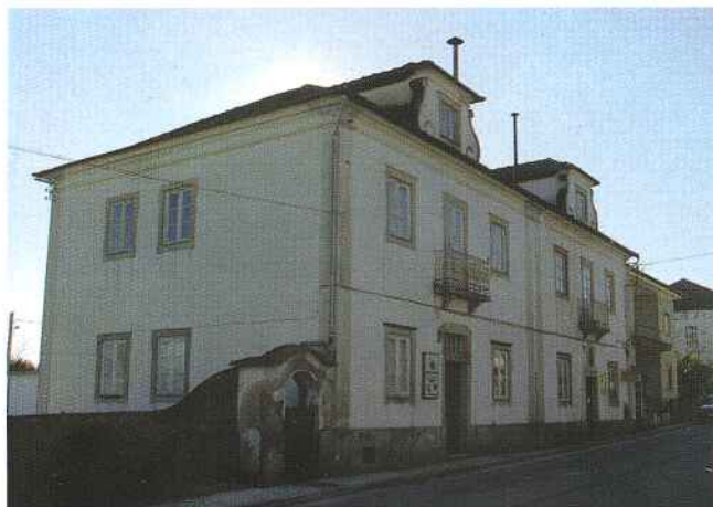
Fachada da “Casa dos Magistrados”
