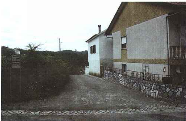
Arruamento em calçada em Fonte da Guisa - Figueiró dos Vinhos
