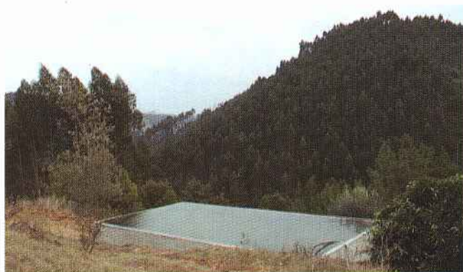
Novo Ponto de Água para o combate a incêndios
