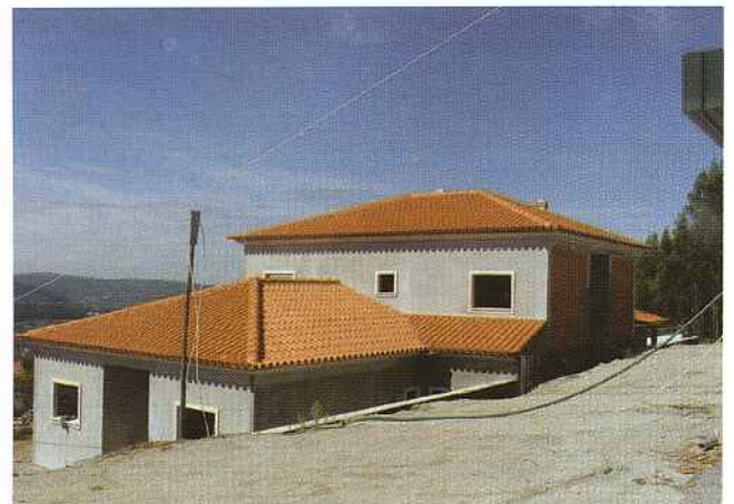
Edifício em construção da Comissão de Melhoramentos de Aguda
