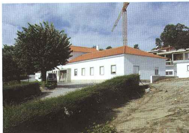
Hospital da Misericórdia em fase de conclusão
