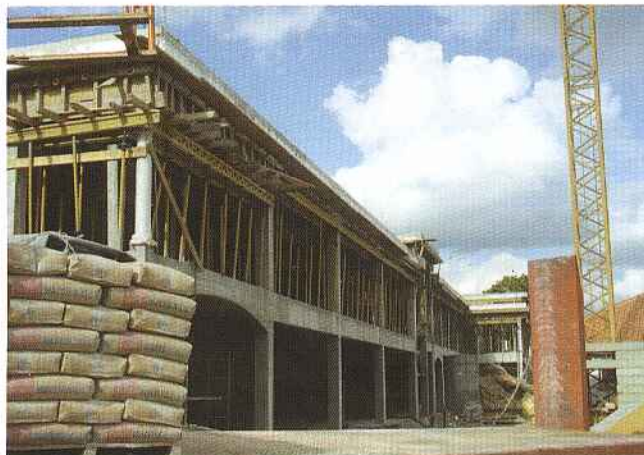
Obras do Centro Comunitário de Figueiró dos Vinhos
