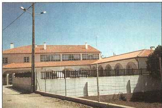
Ampliação do Centro de Dia de Arega.
