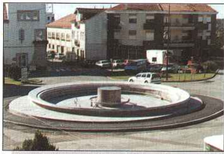
Fonte Luminosa em acabamento.
