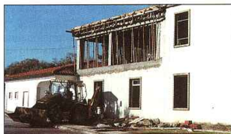
Reconversão em U.A.I. do antigo Hospital
