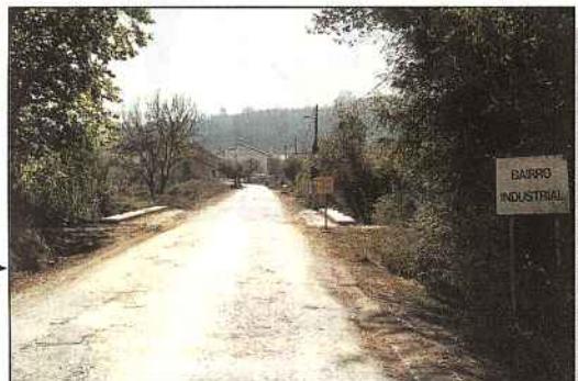
Preparação de "Caixa" para alcatroamento.
