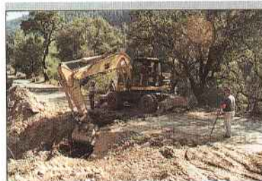
Obras na estrada 237 (Almofala - Barragem da Bouçã)
