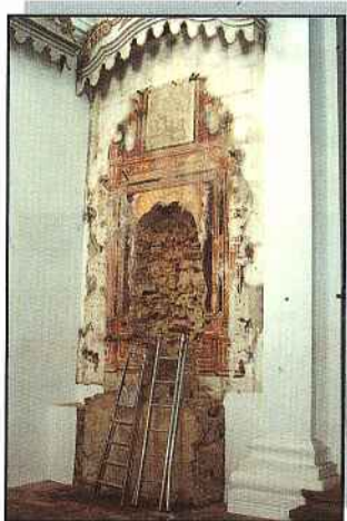
Recuperação interior da Igreja do Convento
