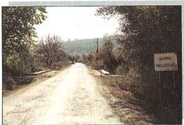
Alargamento do Pontão do Bairro Industrial. Vai ser aplicado tapete entre o I.C. 3 e Almofala (E.N. 237).
