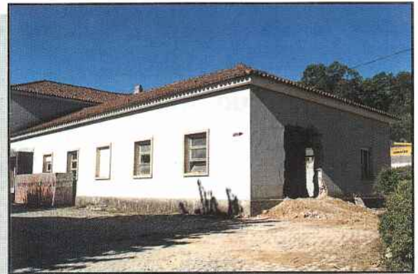
Antigo hospital da Misericórdia de Figueiró dos Vinhos.
