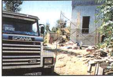
Construção de uma cabine de manobras.
