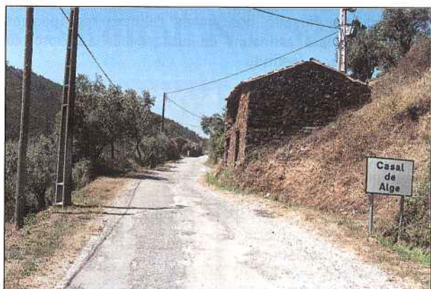
A beneficiação da estrada Enhecamas (Estrada 350) - Foz de Alge compreende uma variante que desloca o trânsito do centro da povoação de Casal de Alge
