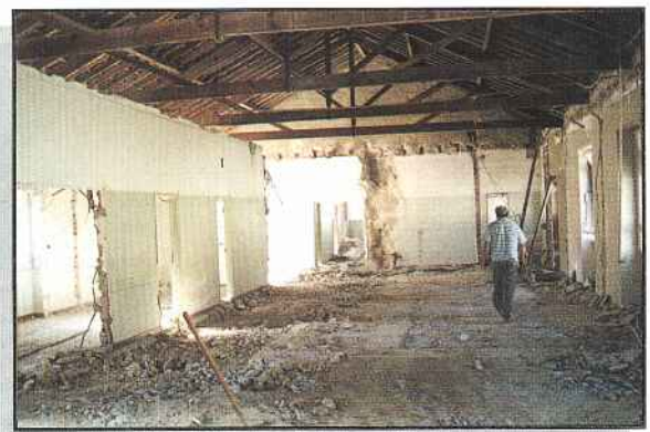
Obras de reconversão no antigo hospital da Misericórdia para adaptação de uma UAI.
