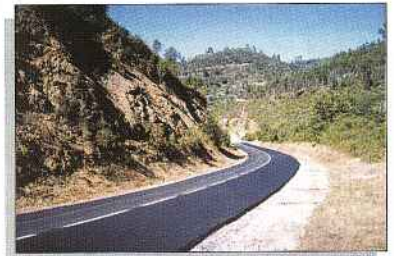
Repavimentação da E.M. 517, no troço Ponte de Arega - Arega (centro)
