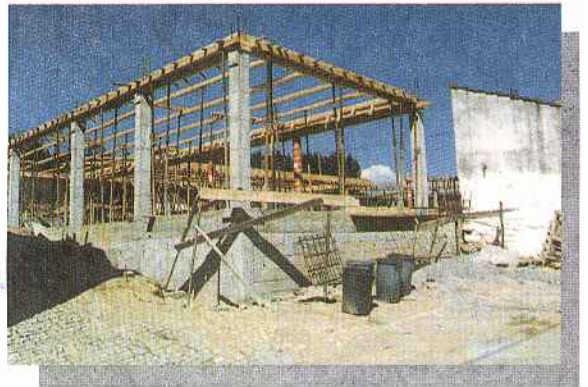
Futuro Mercado de Arega em fase de construção.
