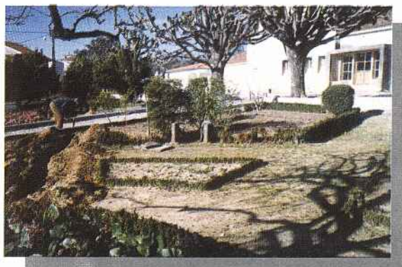
Antigas instalações do Hospital da Santa Casa da Misericórdia.
