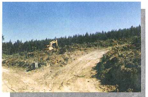
Preparação do terreno para instalações industriais.
