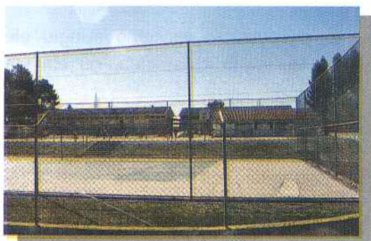
Pavilhões pré-fabricados a demolir.
