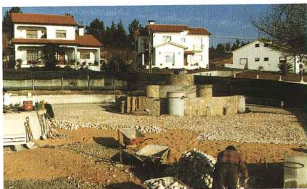
Entrada norte de Figueiró
