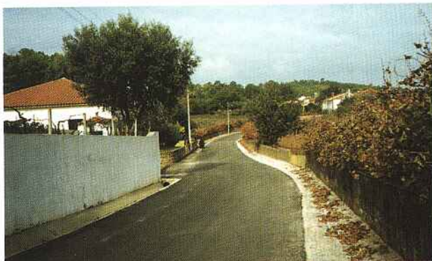
Caminho Municipal acabado de beneficiar.
