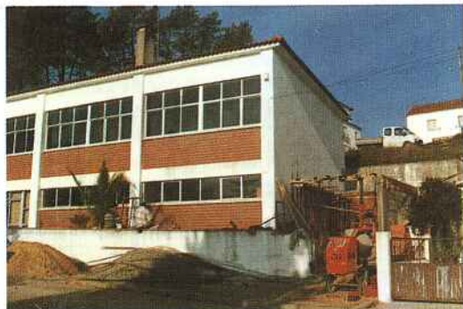
Garagem em construção.
