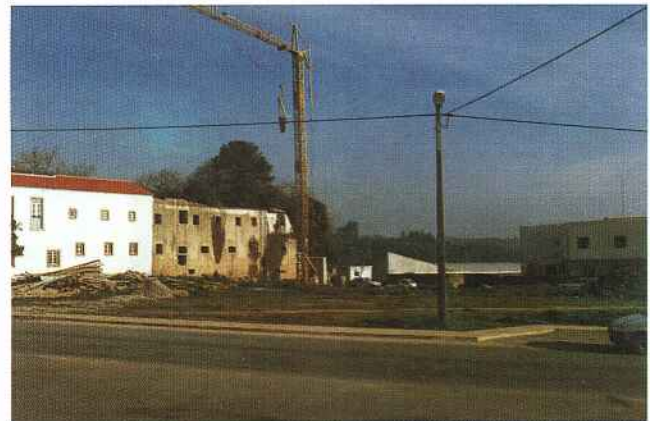
Preparativos para o início da construção da Biblioteca Municipal
