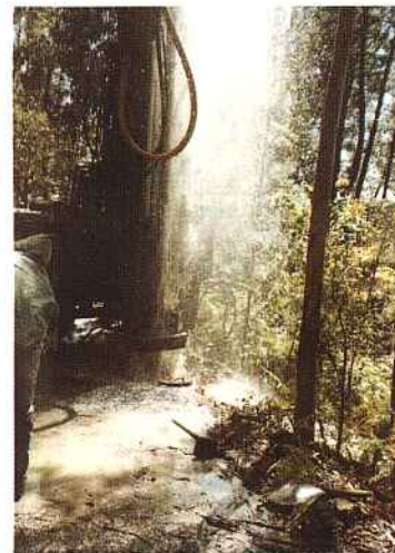
Nova captação de água
