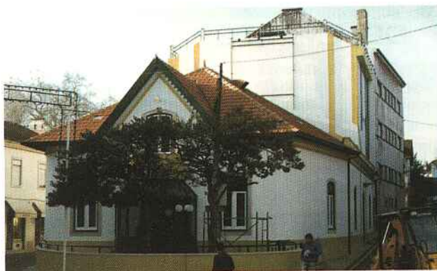
Clube Figueirense - Casa de Espectáculos Obras em fase de conclusão.
