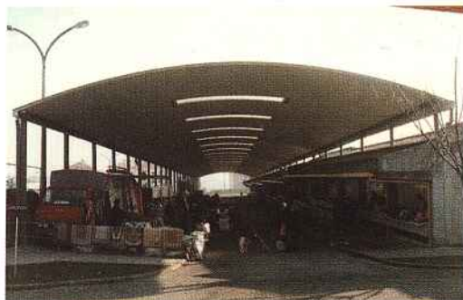
Aspecto de uma zona do Mercado com a cobertura já aplicada
