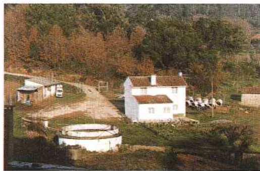
ETAR de Figueiró dos Vinhos.
