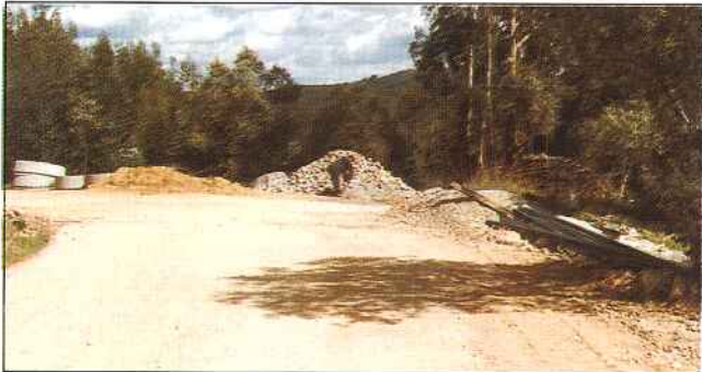
Obras de abastecimento de água
