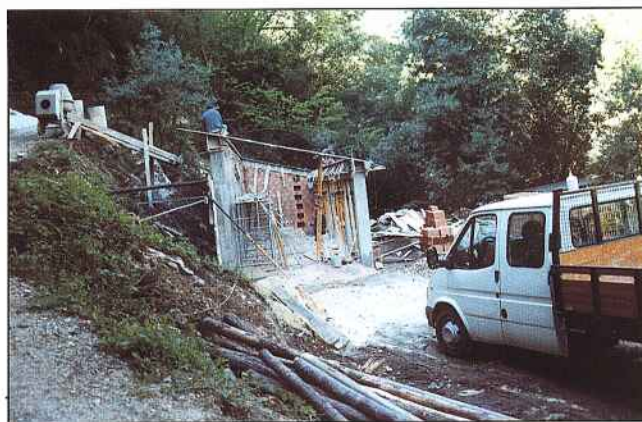
Construção da Praia Fluvial das Fragas de S. Simão
