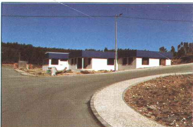
Construção de unidades no Parque Industrial
