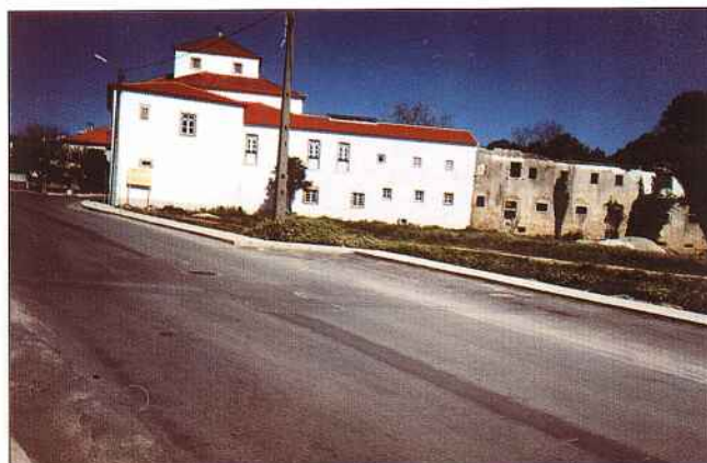
Local de implantação da Biblioteca, à direita, na parte do Convento ainda por recuperar e terrenos contíguos
