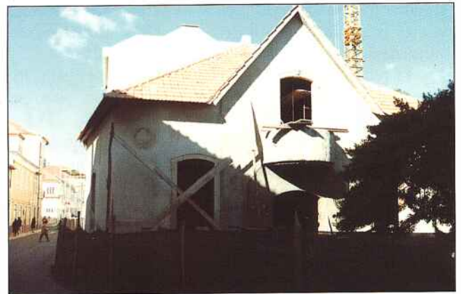
Ampliação e remodelação do Clube Figueiroense
