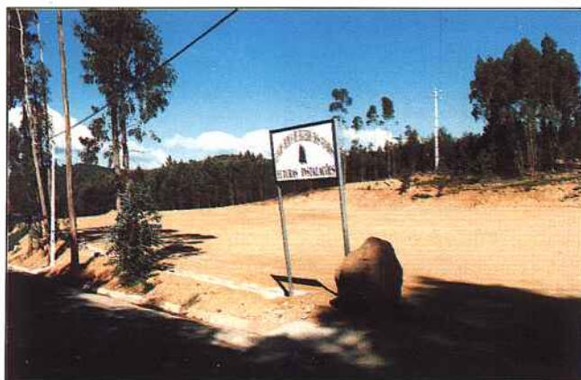
Terrenos do Centro Hípico. São visíveis os trabalhos de drenagem efectuados
