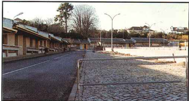
INÍCIO DAS OBRAS DE COBERTURA DE ALGUNS ARRUAMENTOS NO MERCADO.
