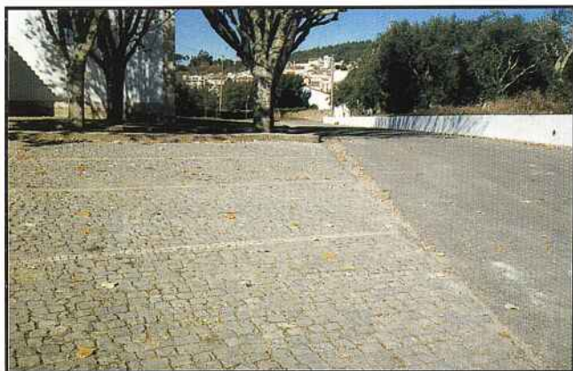
ARRUAMENTO DE ACESSO AO CEMITÉRIO.
