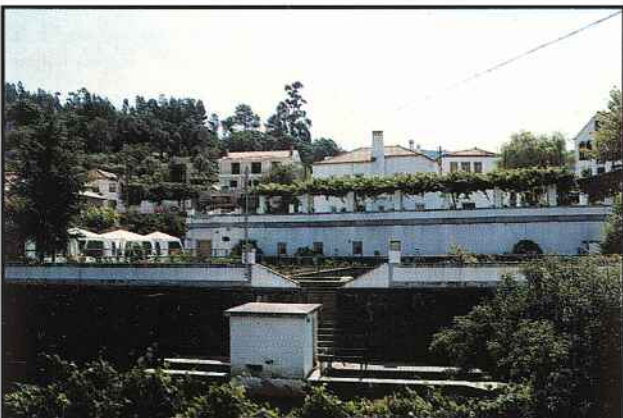
NO VIVEIRO DE TRUTAS DE CAMPELO COMEÇOU A CONSTRUÇÃO DE UM BAR-ESPLANADA. SITUAR-SE-Á NA FAIXA ESQUERDA, JUNTO À PRAIA FLUVIAL.
