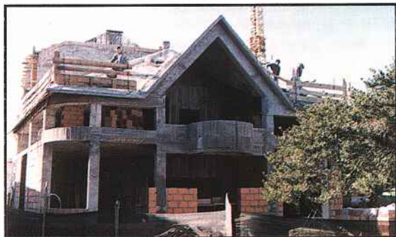
CLUBE FIGUEIROENSE. ASPECTO DAS OBRAS EM MEADOS DE DEZEMBRO.
