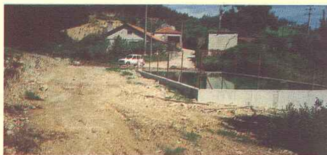
Tanque para apoio aos Bombeiros em Vale do Prado (Arega)
