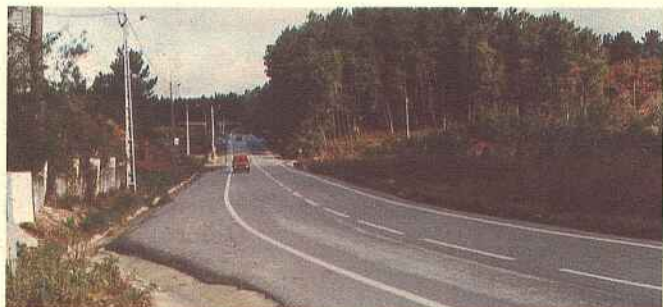
Acesso ao Parque Industrial
