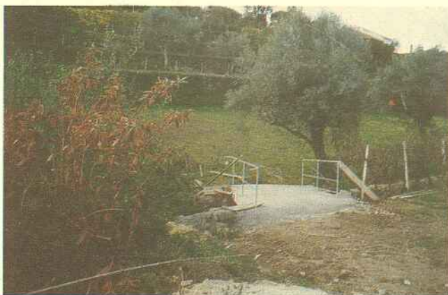
PONTÃO EM ACABAMENTO
