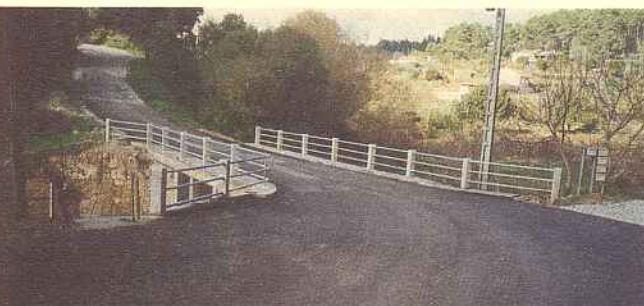
Ponte da Lavandeira, alargada
