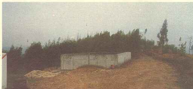
Tanque em Forno Telheiro
