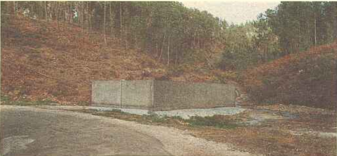
Ponto de água para meios aéreos e terrestres
