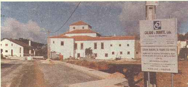
Construção de passeios na entrada Sul
