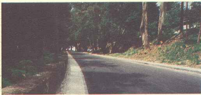
Benfeitoria na Zona da Pedreira
