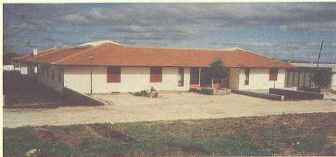
Aspecto do novo Centro de Saúde. Concluído fisicamente, está a ser apetrechado para entrar em funcionamento
