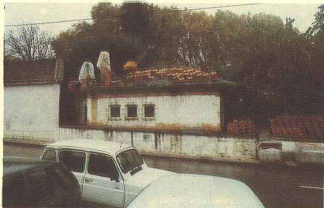
OBRA DE AMPLIAÇÃO DO BAR DO PARQUE
