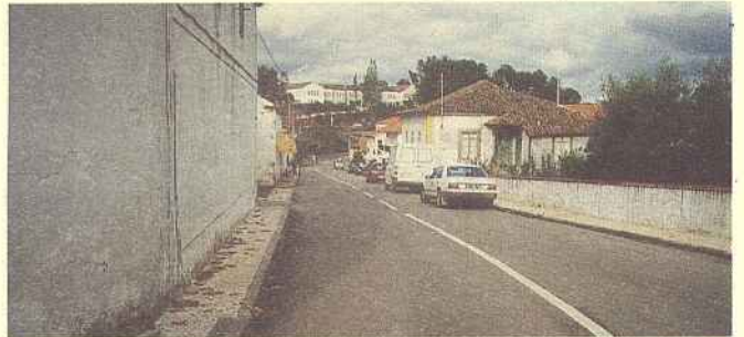
Passeios e drenagem de águas junto ao lado Sul do Parque Municipal
