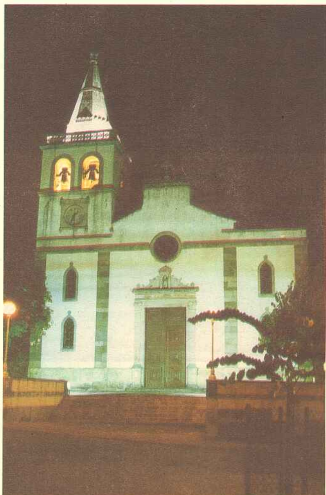
Iluminação do Centro Histórico. Igreja Matriz (Monumento Nacional)
