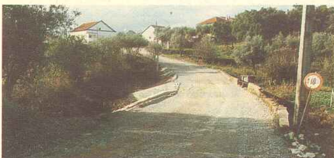
Alargamento da ponte do Bairrão
