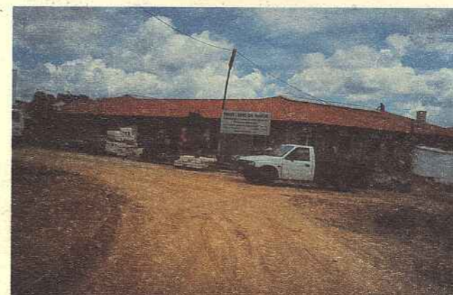
CENTRO DE SAÚDE (Novas instalações em vias de conclusão)
