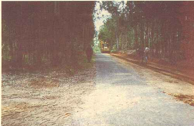
Serra de Aguda. Montagem da conduta entre Aguda e o depósito que abastecerá o Fato, e outros lugares
