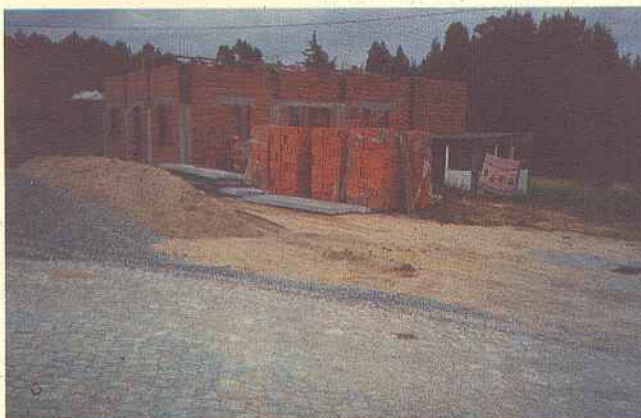
Fase actual dos trabalhos
