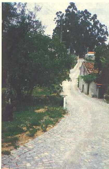
Calçada recentemente construída
