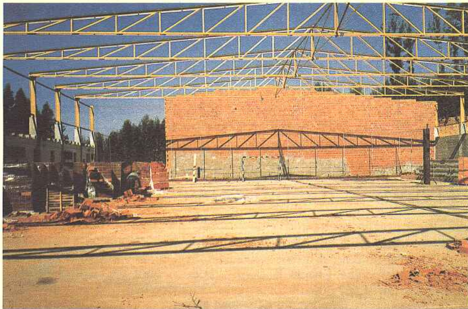
Trabalhos de cobertura do Polidesportivo de Aguda.
