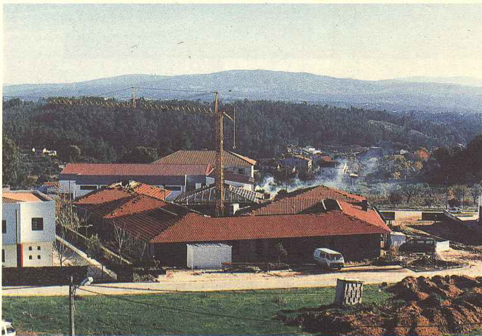
Aspecto da Construção do novo Centro de Saúde
