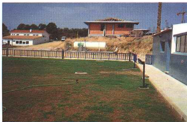
Ao fundo, e no complexo de módulos do novo Centro de Saúde, o pavilhão destinado ao S.A.P. (Serviço de Atendimento Permanente)
