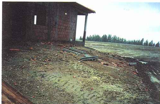
Edifício de apoio à Helipista.
