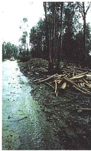
Depósitos de madeira e lixo desviam o curso das águas, inundando os pavimentos.
