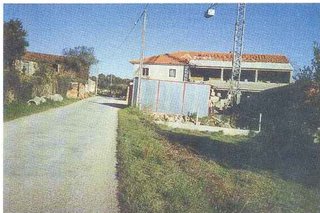
Centro de Dia em Construção
