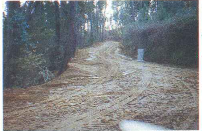
Caminho em Construção.
