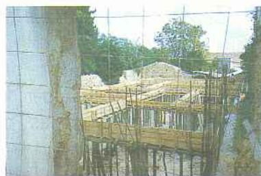
Reconstrução de prédio em ruínas
