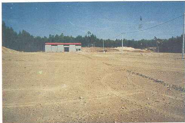
Unidade industrial em construção.
