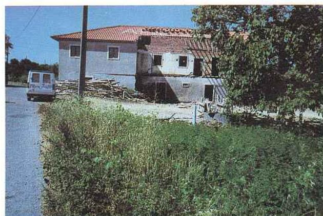
Futuro Centro de Dia de Arega em construção
