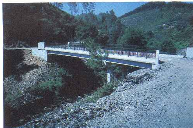
Ponte da Machuca. Liga os Concelhos de Figueiró e Penela e será atravessada pelo Rallye de Portugal / 1995
