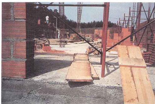
Unidade Fabril em construção
