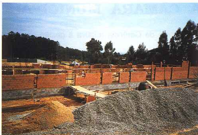
Unidade Industrial em construção
