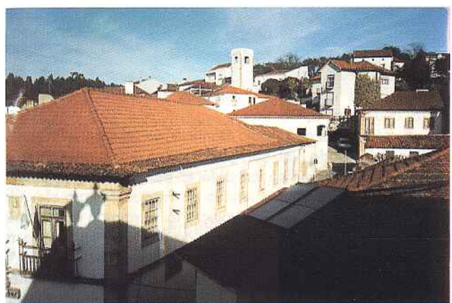
Torre restaurada. Miradouro aliciante.
