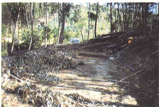
Caminho florestal ligando a E.M. 1128 a Agria Grande. Plataforma de 5 metros obstruída por materiais lenhosos. Sem comentários!
