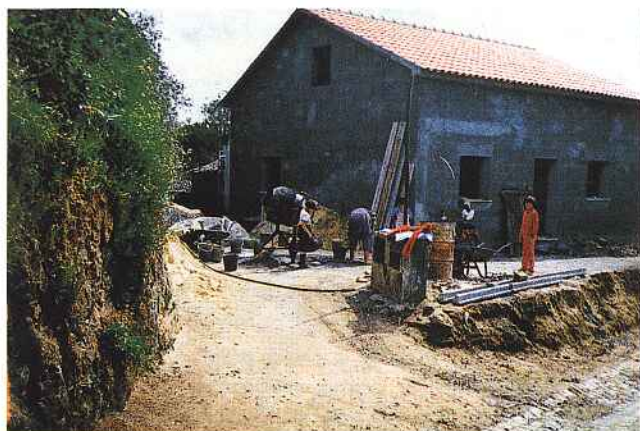
Construção de habitação (Aguda)
