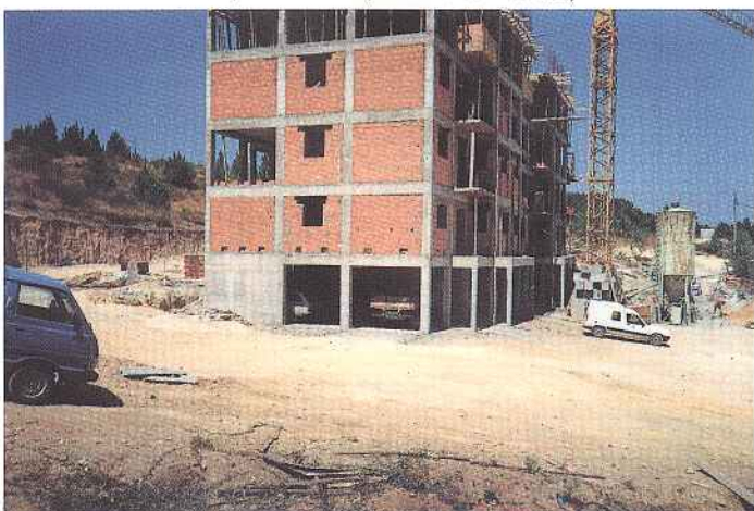
Habitação Social: Bloco em construção
