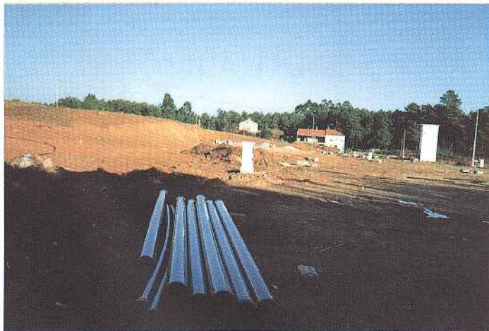
Parque Industrial (ultima-se a 1ª Fase)
