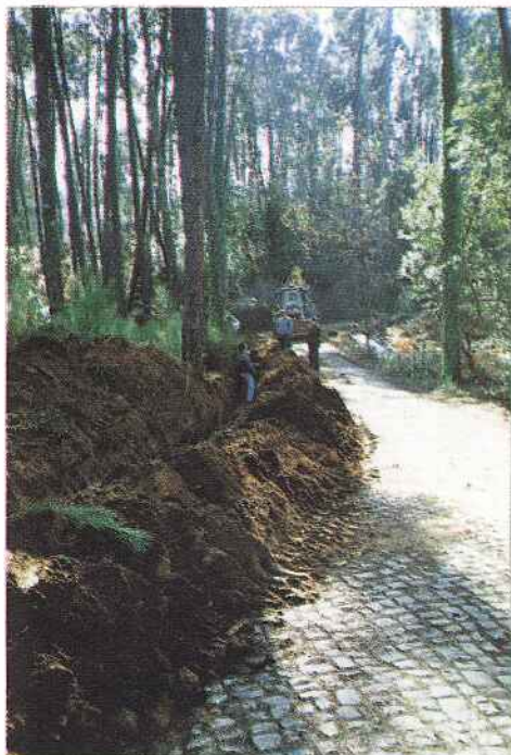
O Presidente da Câmara aprecia o andamento dos trabalhos
