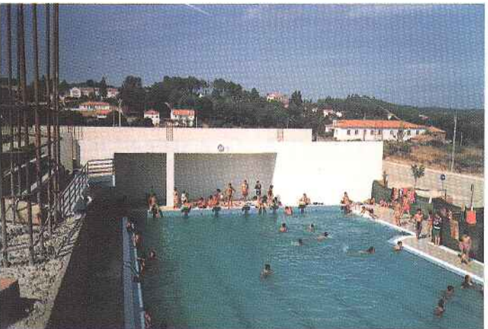
Piscina Municipal (concluída a 1ª Fase)
