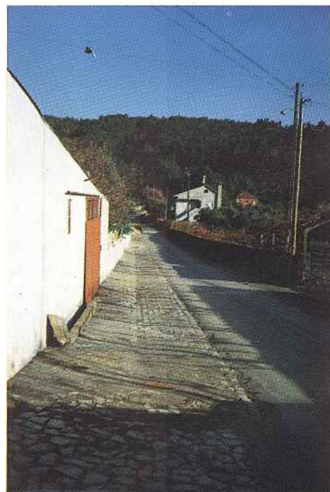
Beneficiação de bermas (em calçada) em Vilas de Pedro, ao longo da E.M. 521
