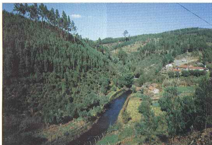
Entre-Águas. A "passadeira" de madeira dará lugar a um pontão metálico, já com projecto aprovado.
