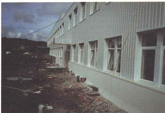
Aspecto da fachada principal
