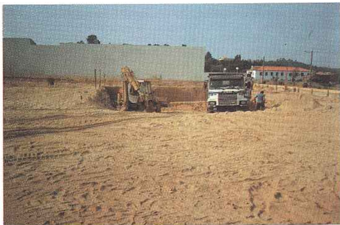
Início da construção
