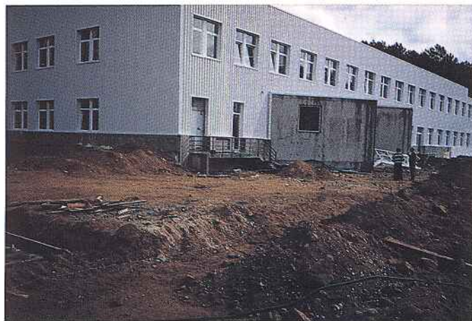
Terminal de Carga
