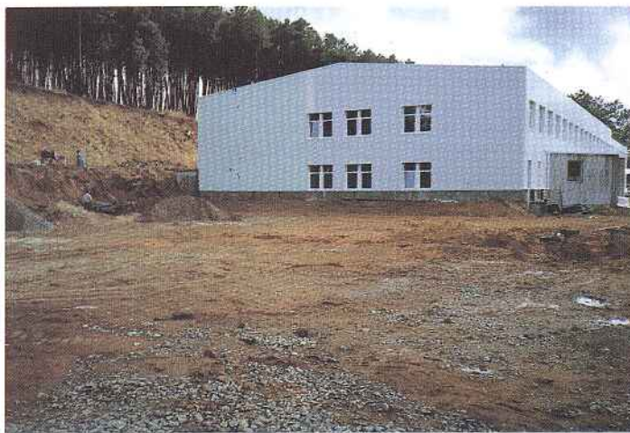
Acesso ao terminal de descarga de matérias-primas
