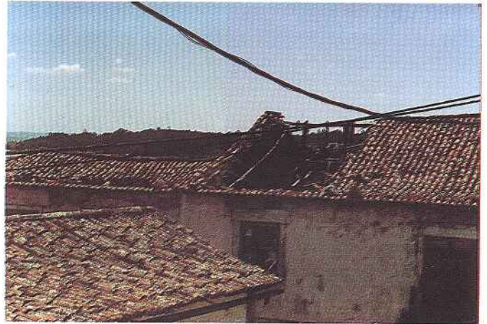
Aspecto anterior de Imóvel reconstruído
