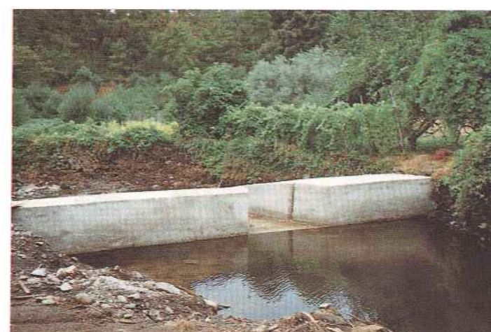
Cais de Enchimento (Alge)
