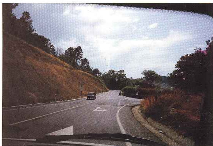
Local do início da beneficiação da E.N. 237 Ponte da Aldeia — Figueiró (adjudicada)
