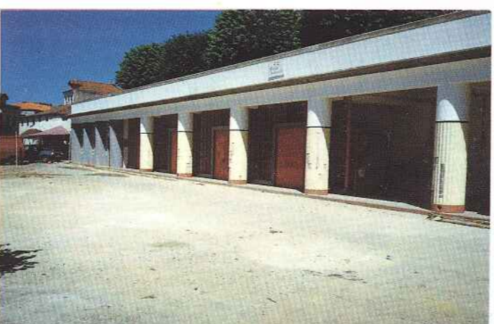
Instalações Rodoviárias em acabamento
