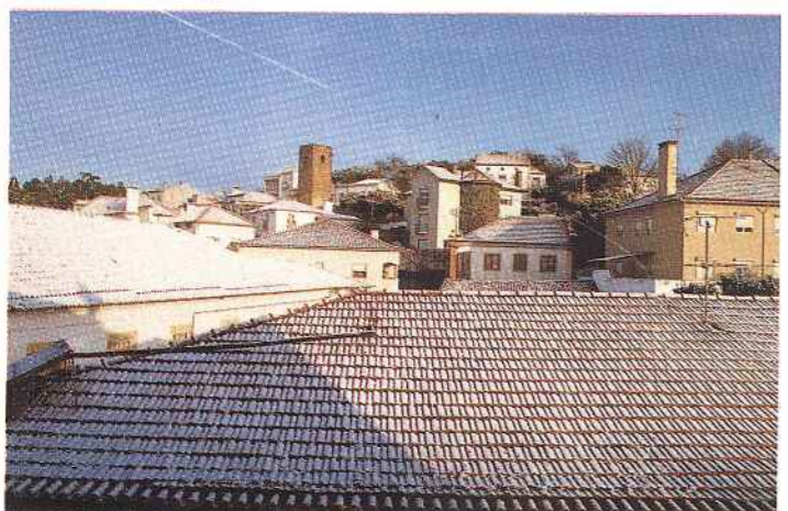
Vista da Torre da Cadeia em reconstrução
