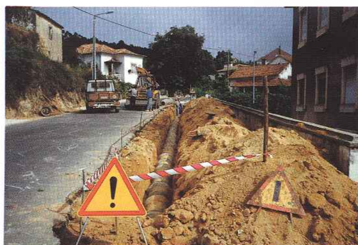
Construção de Passeios na Vila
