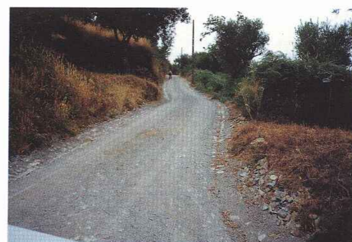
Calçada em Casalinho
