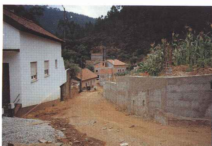
Arruamento em Ribeira de Alge
