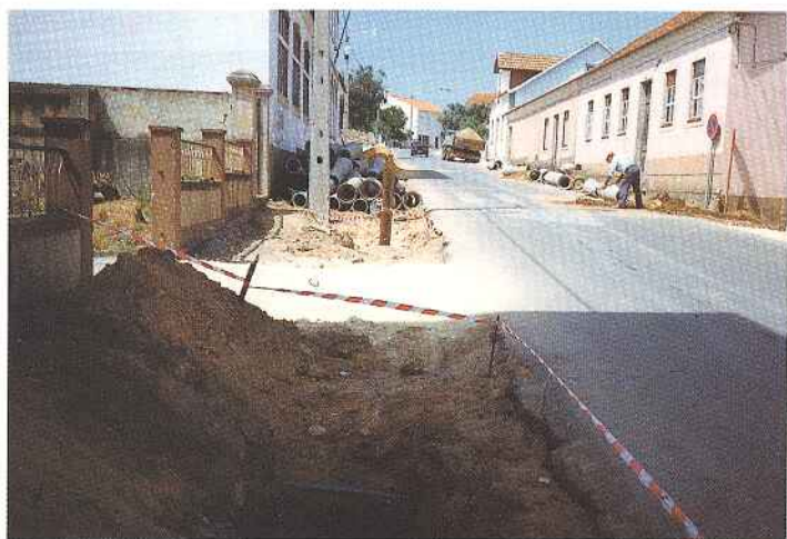
Construção de Passeios e Drenagem de Águas
