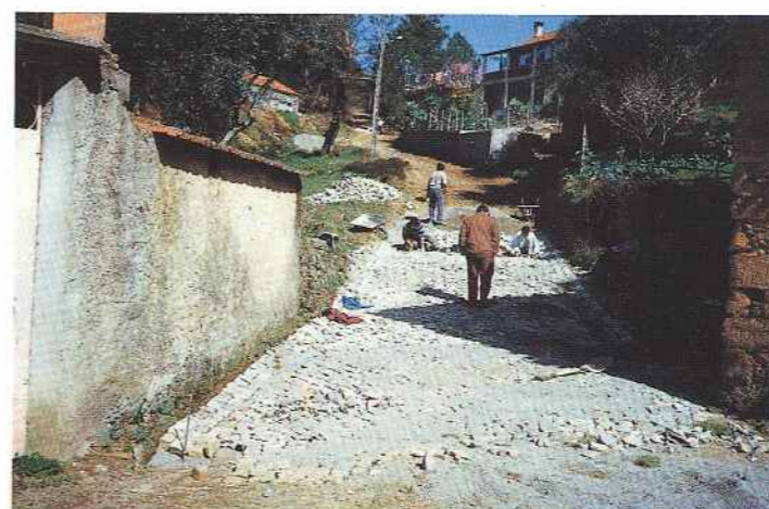
Arruamento em construção
