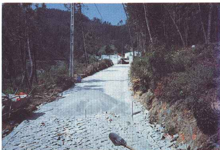
Calçada em acabamento
