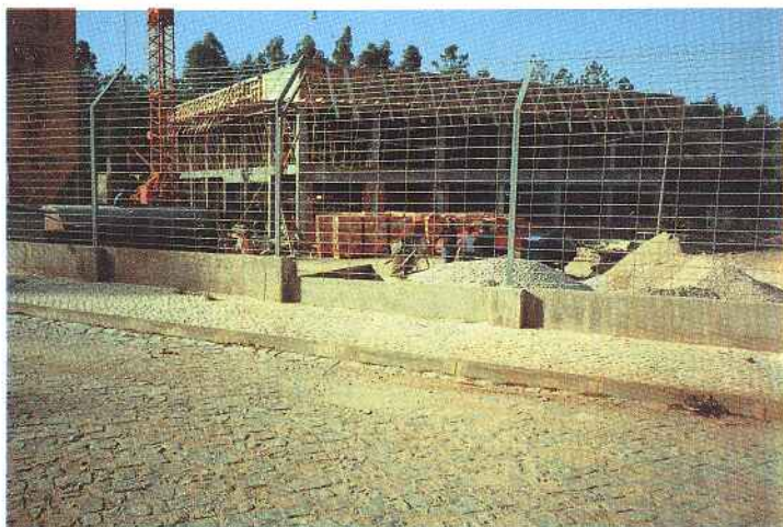
Ampliação da Escola Secundária
