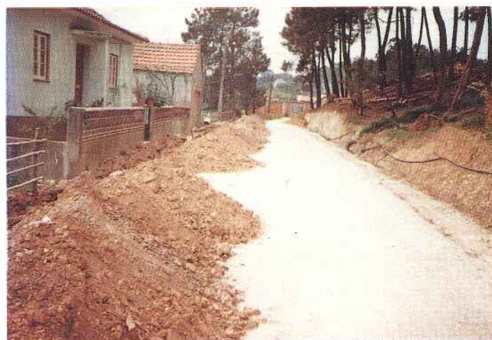
Implantação de Conduta de Água
