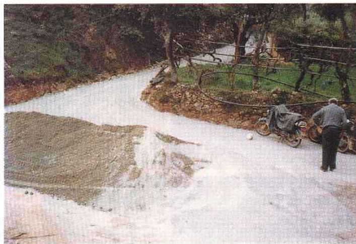
Arruamento em construção
