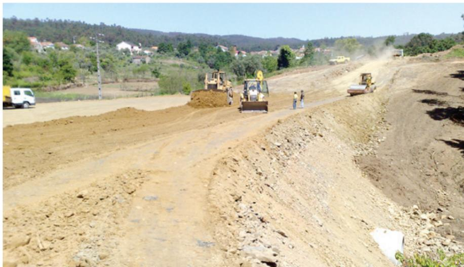
As obras de construção da Variante de Vila Facaia (ligação do IC8, Nó da Adega a Vila Facaia) já se iniciaram e decorrem a um bom ritmo, tendo-se já realizado cerca 70 % das zonas de decapagem (corte de árvores e remoção da vegetação) e 50 % da regularização da plataforma da via de comunicação, com os devidos aterros ou desaterros.
