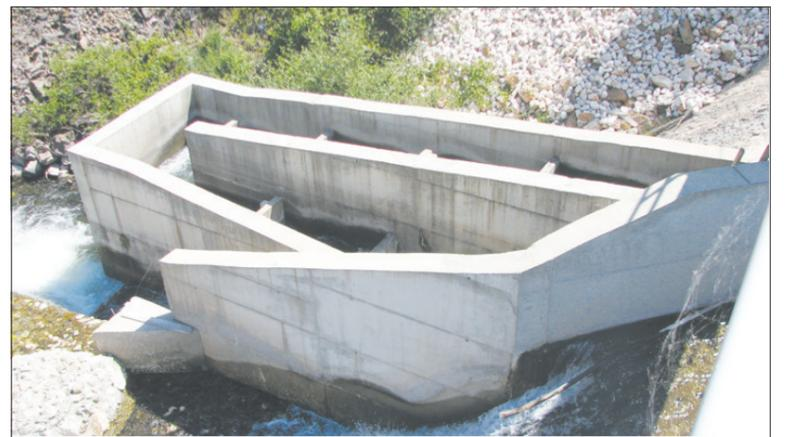
Na foto de cima, pormenor da “escada” por onde o peixe sobe, “contornando” a barreira física que o açude, naturalmente, criou. Um processo curioso onde, através de “degraus” que aliviam a corrente por baixo destes, permite a subida do peixe com menor esforço. Segundo fontes da Secção de Pesca da Desportiva, já por ali terão subido milhares de peixes, principalmente Bogas.
